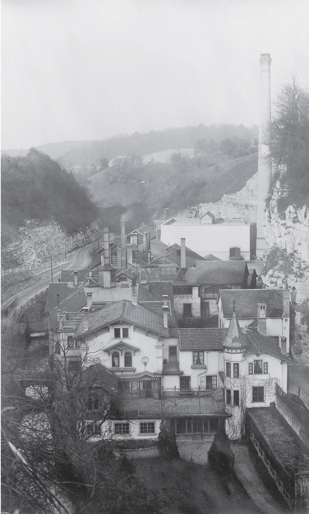
Werk III (Fittingsproduktion) 1900. In den ersten 100 Jahren erfolgte der Ausbau der Schaffhauser Werke von +GF+ stets im Mühltal.
