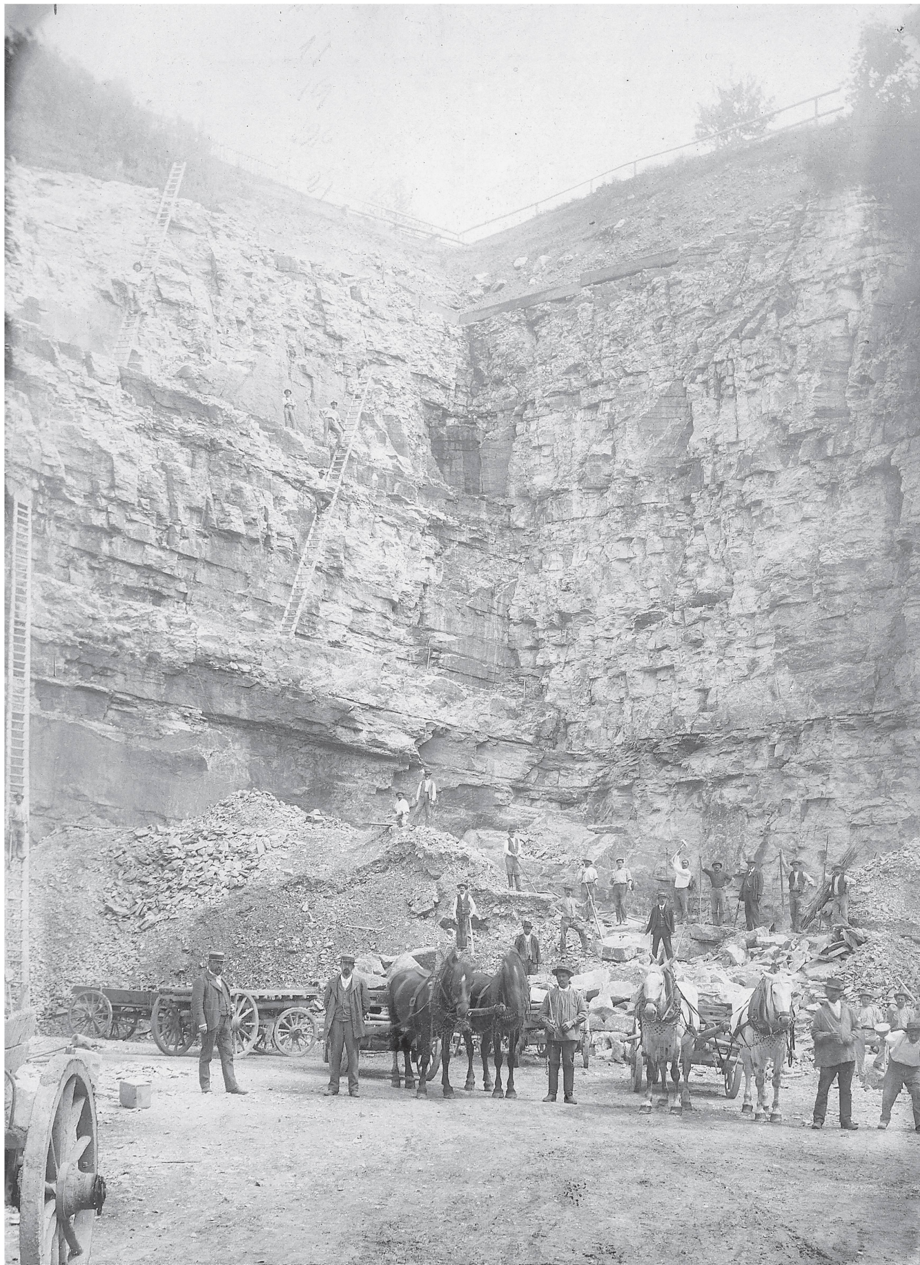
Um für neue Anlagen Platz zu gewinnen, musste +GF+ im Mühlental immer wieder Fels abtragen lassen. Im Bild der Bauplatz für die Glüherei im Werk III 1898. Steine aus dem Mühlental wurden beim Bau des Bahntunnels Schaffhausen-Feuerthalen verwendet.
