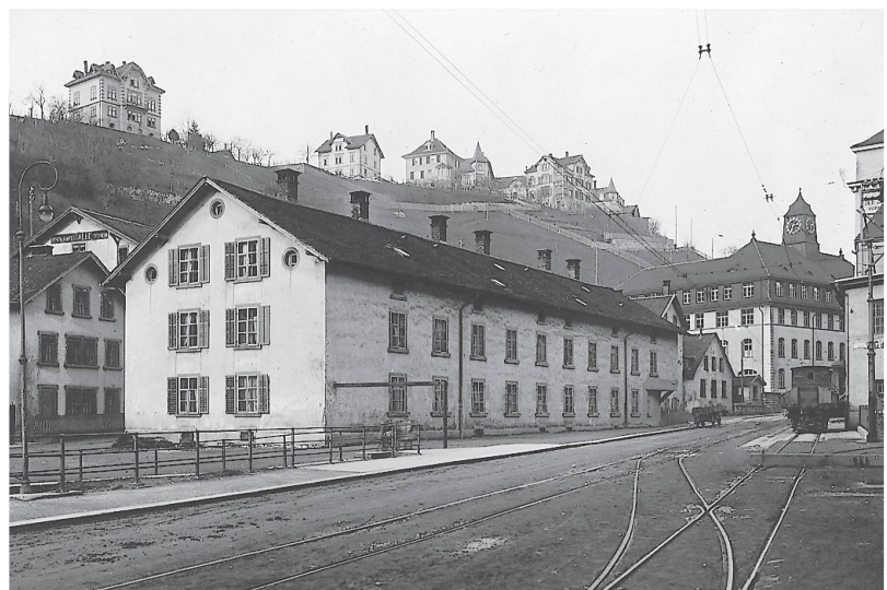
Das erste, 1868 erbaute Arbeiterwohnhaus im Mühlental
