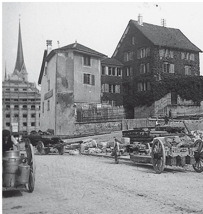
Der nördliche Teil des Wollenhofes wurde abgerissen, um Platz für die 1911 gebaute Urania-Brücke zu schaffen.
