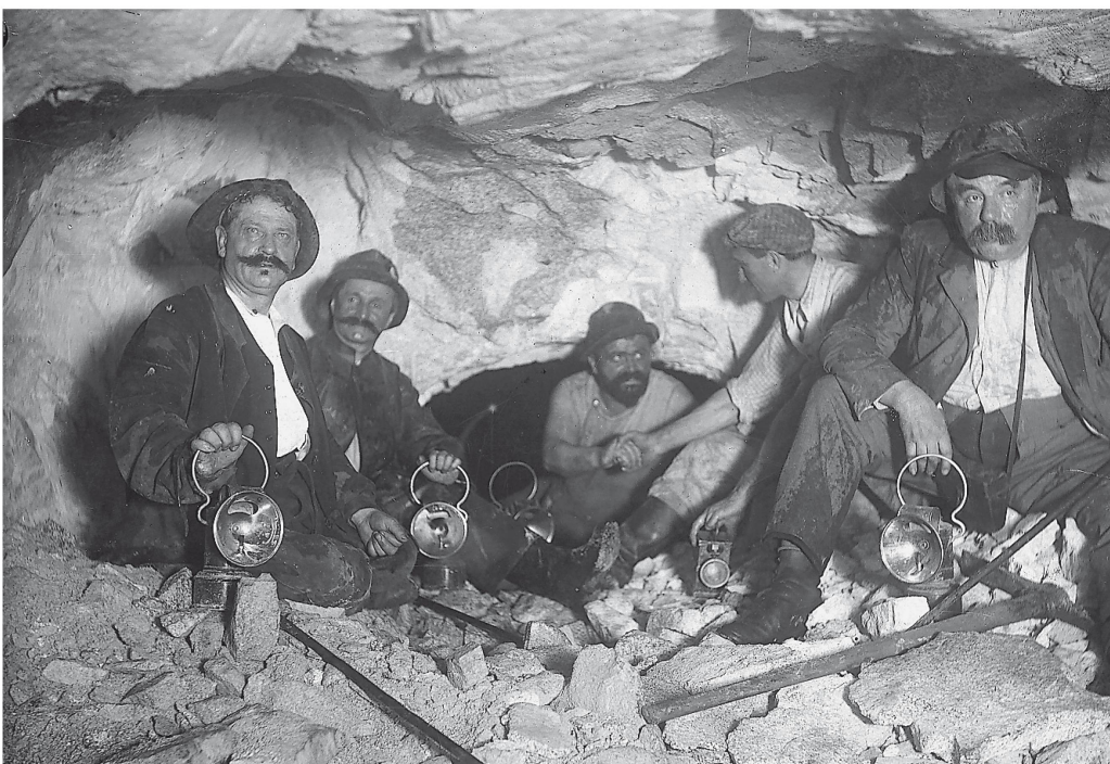
Was Sektionschef F. Weinmann unverzüglich der Bahn-Gesellschaft und der Welt meldete, war für die Ingenieure Anlass zum Gruppenbild unter Tag: Ing. Ch. Moreau (Mitte), Bauleiter Süd, reicht dem Bauleiter Nord, Ferdinand Rothpletz, die Hand. Sie sind flankiert von den Unternehmer-Ingenieuren Victor Prud'homme und Louis Wiriot (links) und von Direktor Zürcher (rechts).
