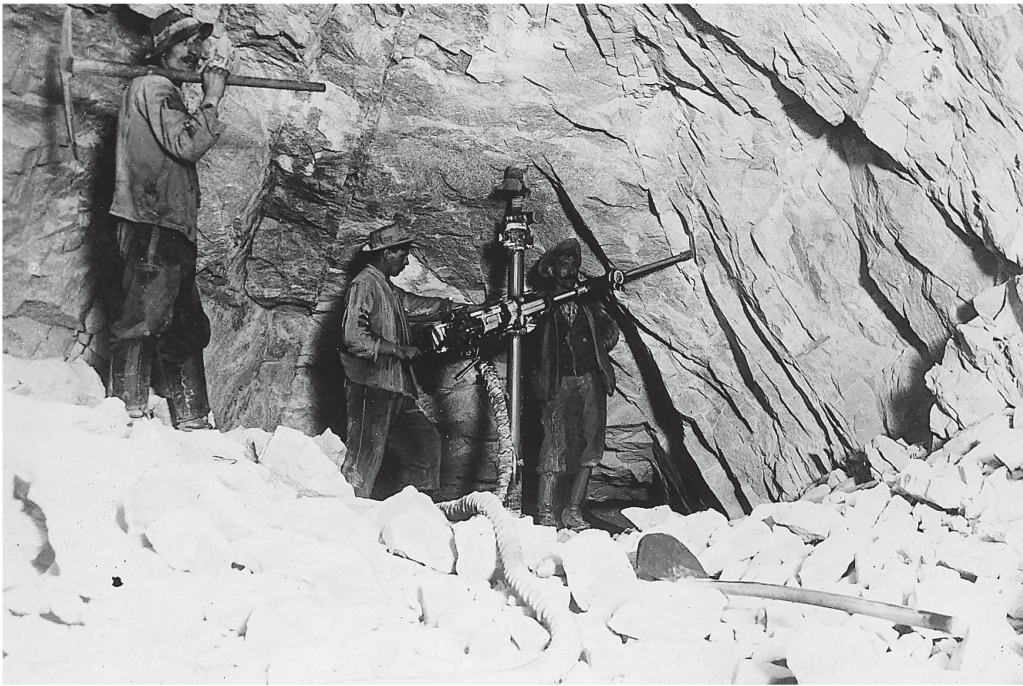
Arbeiter mit pneumatischer Bohrmaschine im Lötschbergtunnel
