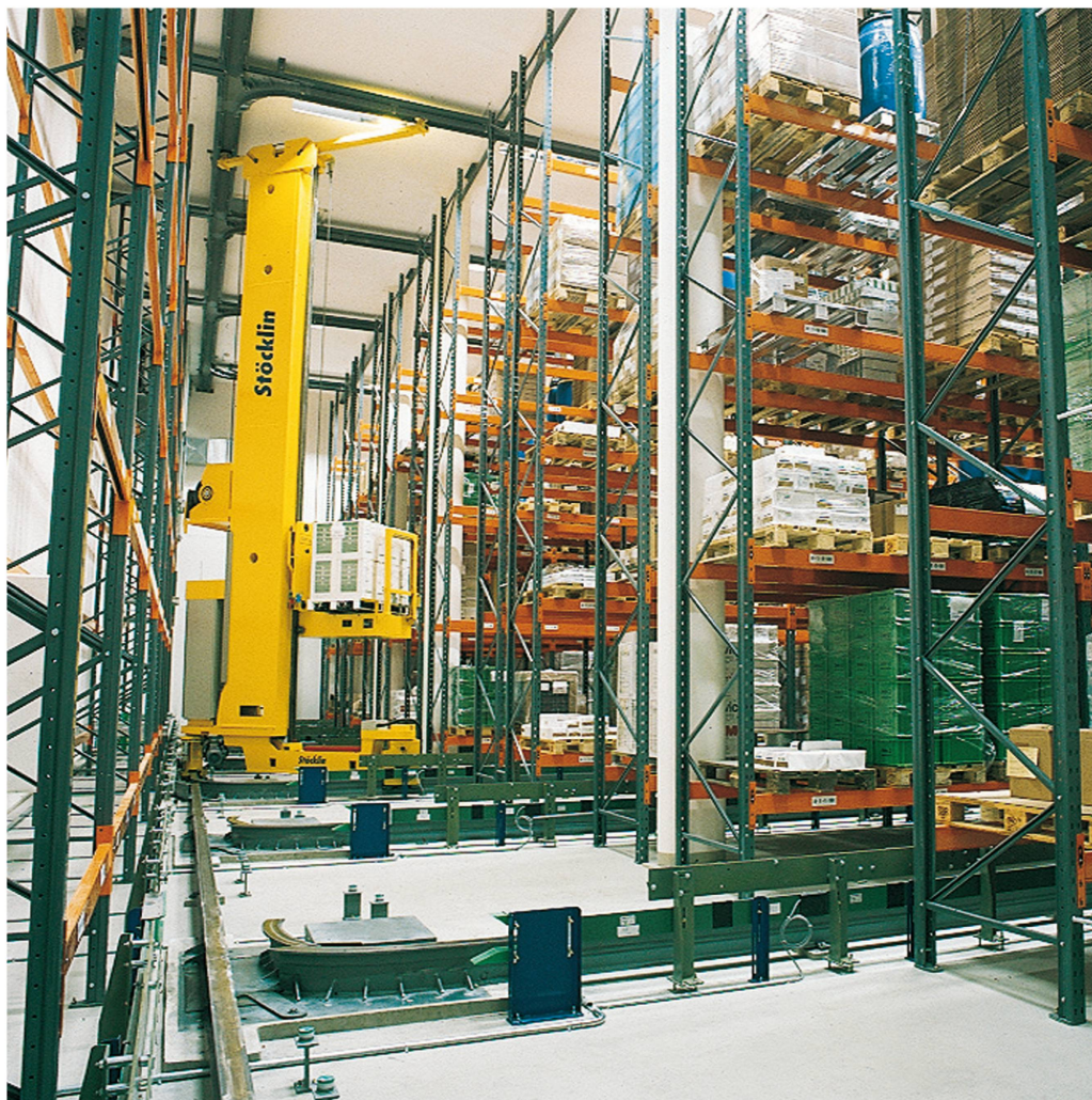
Das unterirdische Hochregallager
