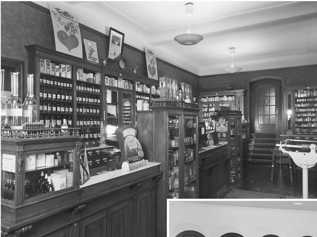
Die Apotheke wurde immer wieder modernisiert: oben Zustand vor, unten nach dem Umbau von 1950; Mitte Teilansicht der heutigen Apotheke
