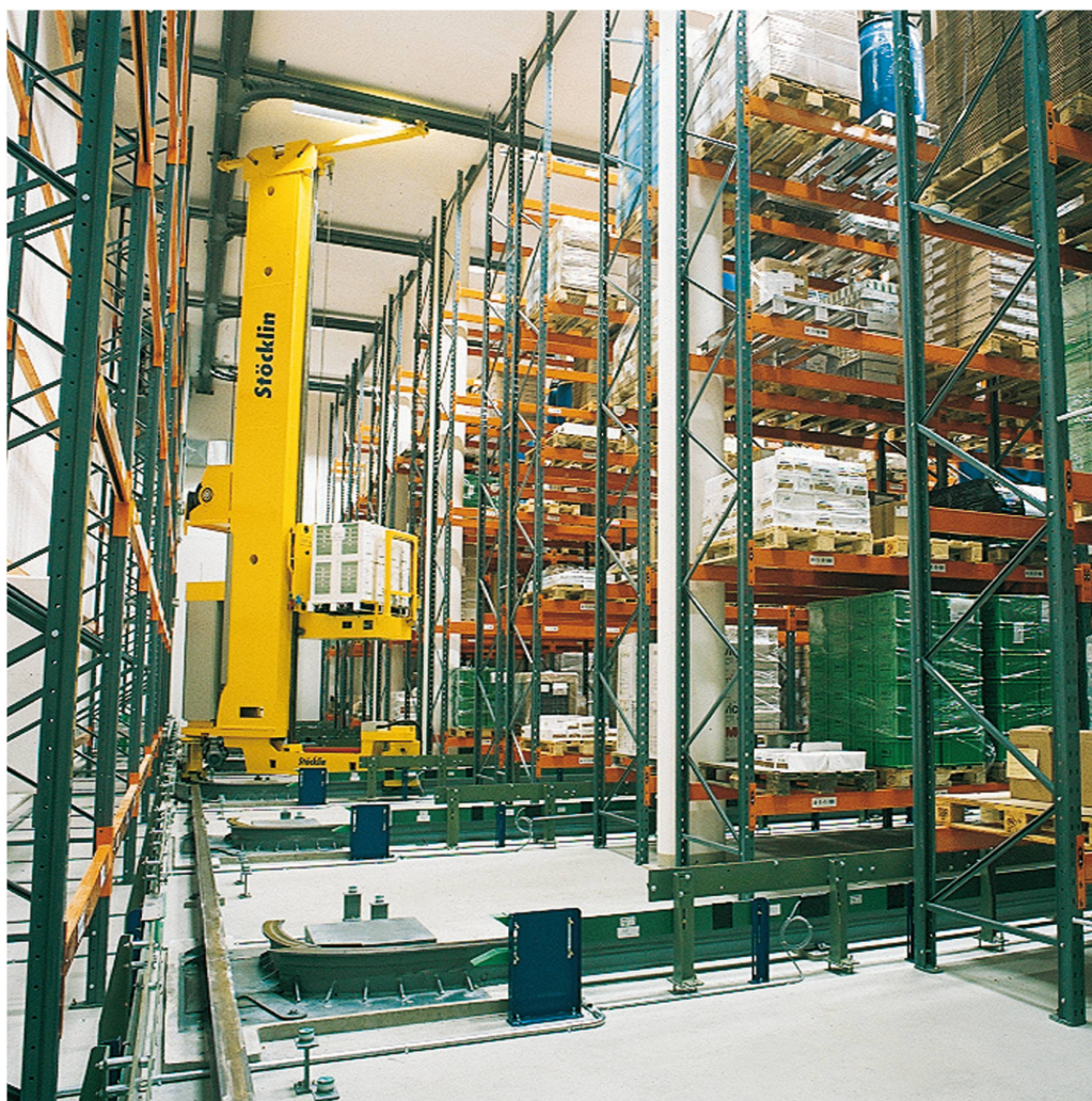
Das unterirdische Hochregallager
