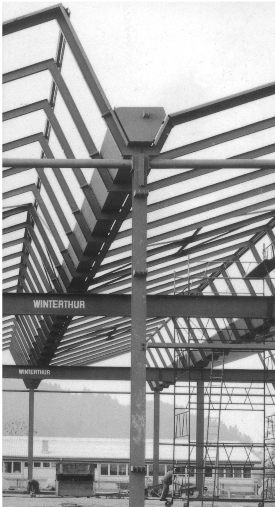
Geilinger-Shed. Gut erkennbar die Rinne, die als tragendes Element dient
