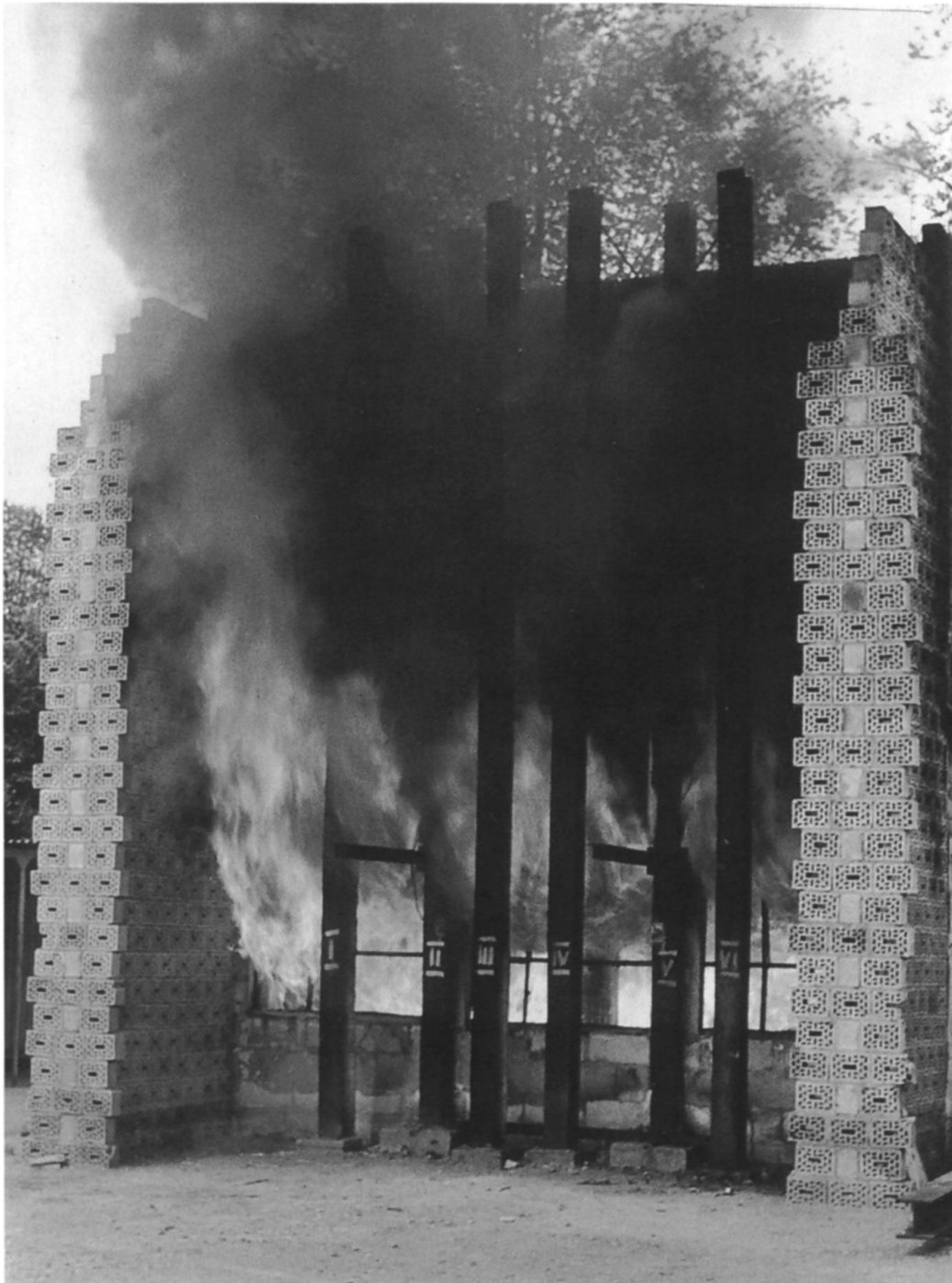
Brandversuche mit Stahlstützen auf dem Werkgelände «Grüze». Solche Experimente lieferten ab Ende der 1940er Jahre erstmals realistische Informationen über das Verhalten von Stahlbauten bei Bränden.
