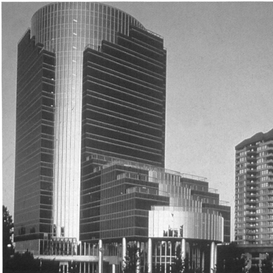
11000 m 2 HIT-Fassade am Gateway Station Tower, Vancouver, die vom kanadischen Lizenznehmer realisiert wurde
