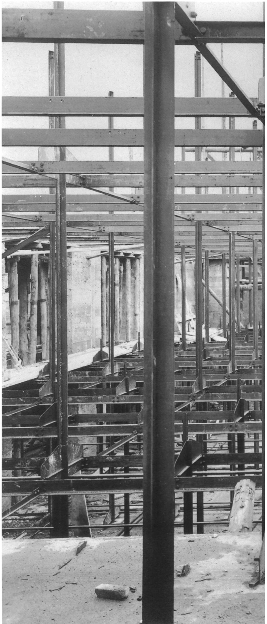
Skelettbau der Stadtbibliothek Winterthur um 1916. Die Ständer und Riegel der Bücherregale bilden zugleich die Tragkonstruktion.
