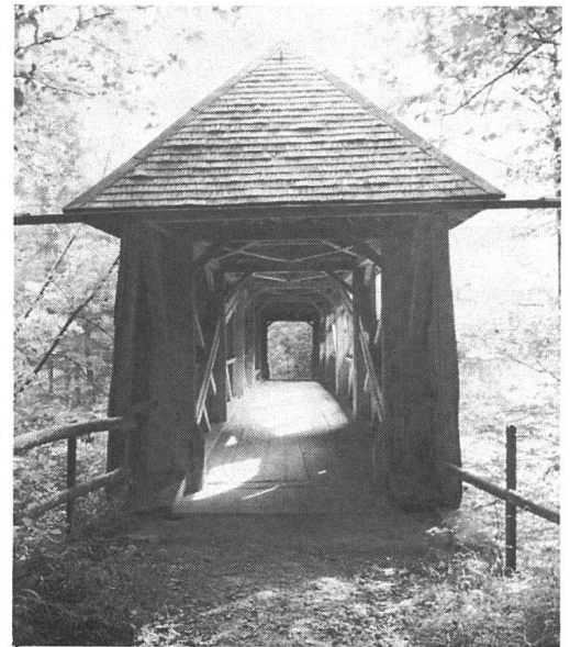
Urnäschbrücke zwischen Hundwil und Herisau AR, 1778 Blick von der Hundwiler Seite gegen den Eingang der schindelgedeckten Brücke
