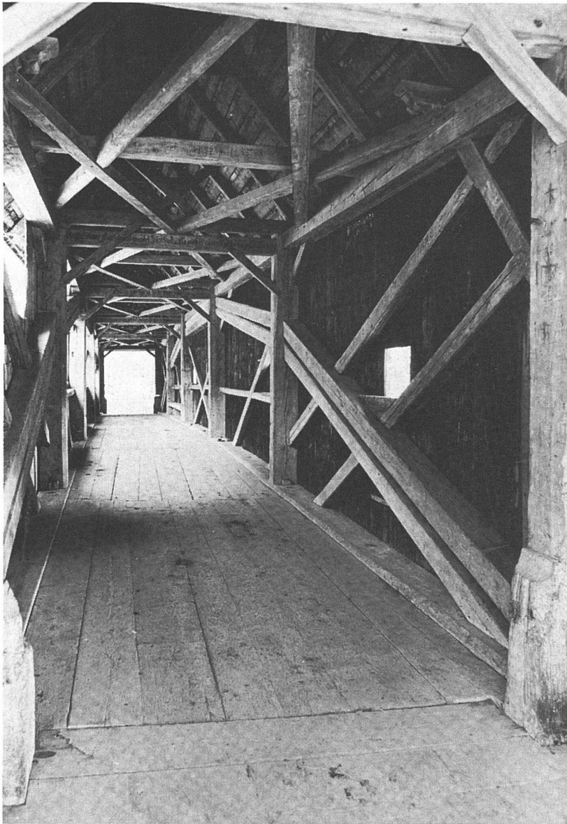
Urnäschbrücke, Hundwil AR Das Hängewerk mit einem doppelt geführten, fünfseitigen Stabpolygon überspannt 29 m.
