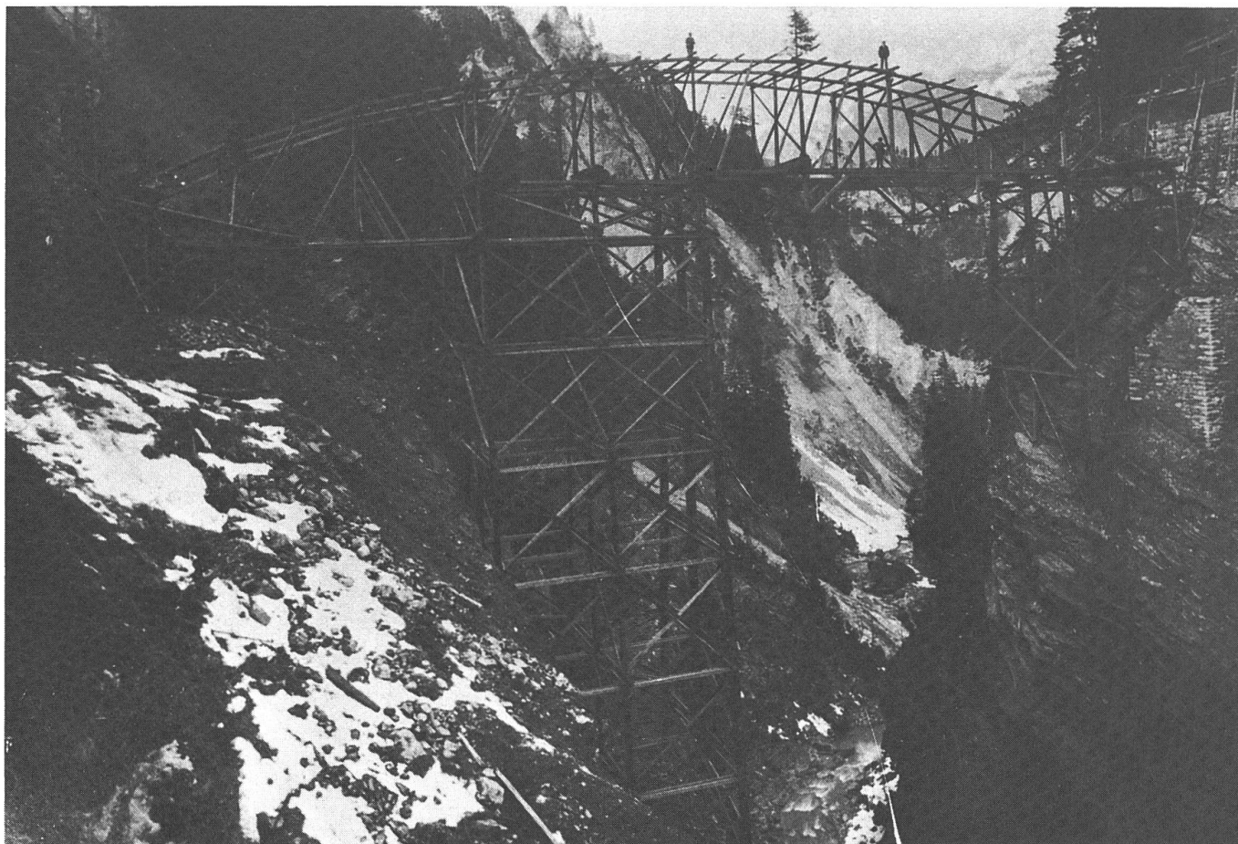
Montagegerüst der Brücke im Versamer Tobel
