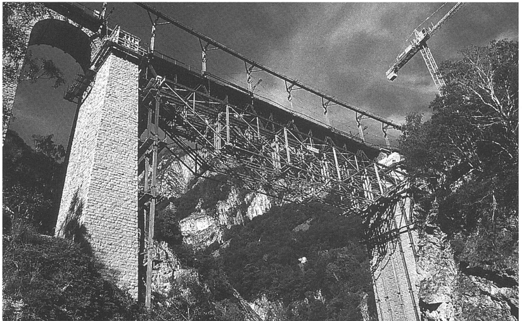
Gerüst Baltschieder- Viadukt der BLS an der Lötschberg-Südrampe 1989
