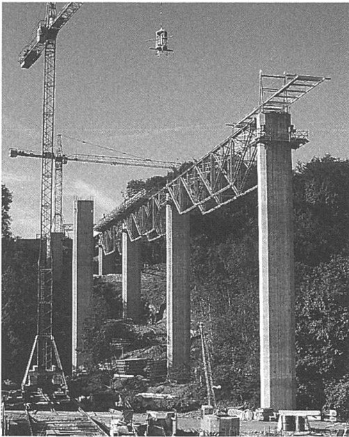
Gerüst N-1-Brücke über den Talent (VD) 1978
