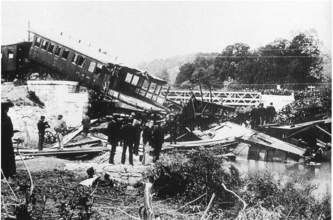
«Das grösste kontinentale Eisenbahnunglück», der Einsturz der Eisenbahnbrücke über die Birs bei Münchenstein am 14. Juni 1891
