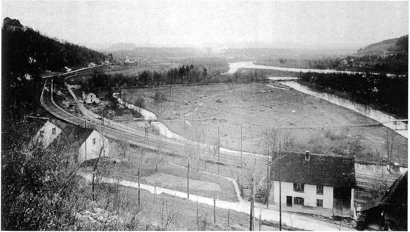
Das Gelände der Zementfabrik «Holderbank» vor Baubeginn (links oben das Schloss Wildegg)...
