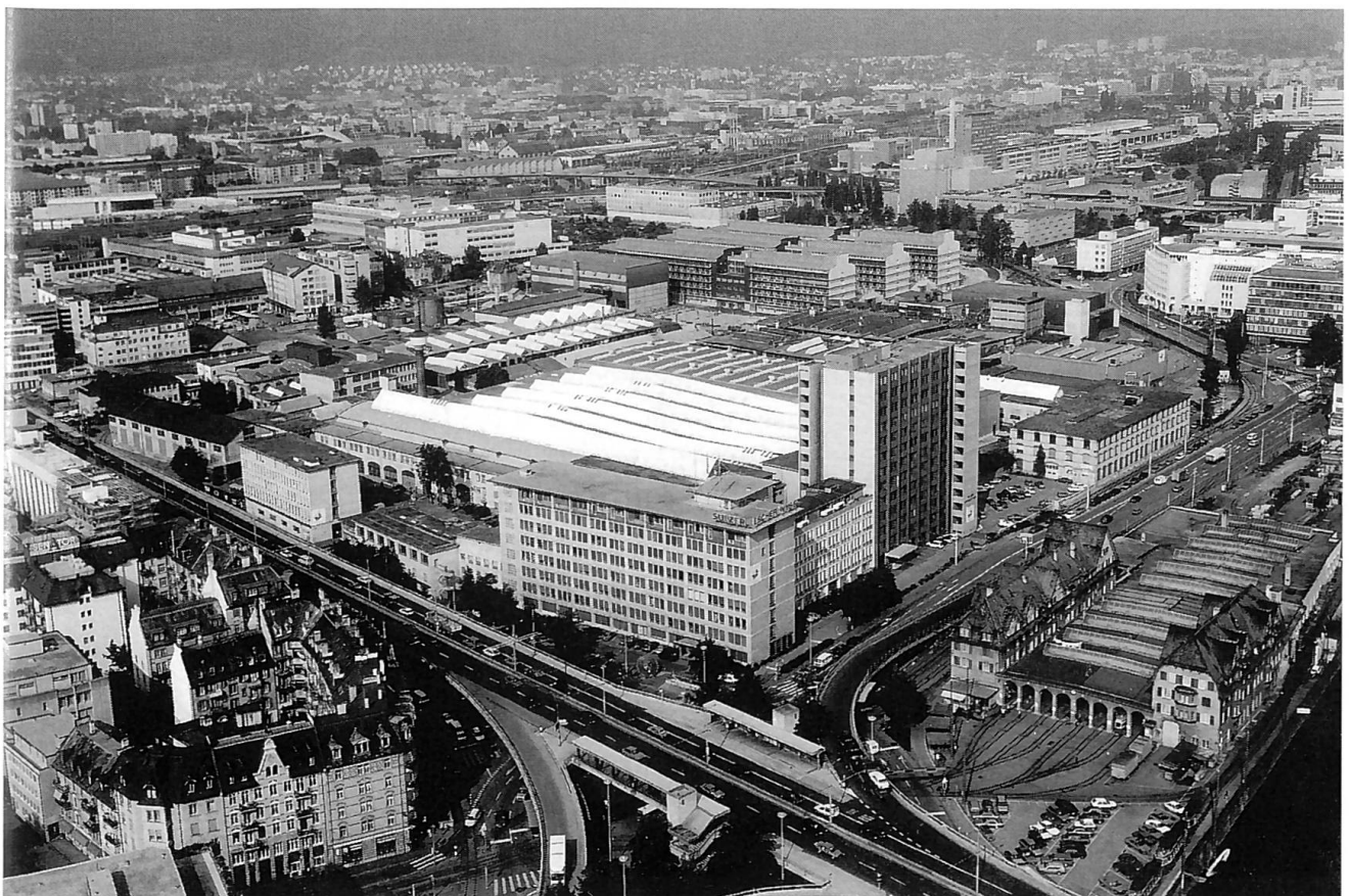
Escher Wyss 1993 mit neuen Werkhallen und dem 1955 bezogenen Bürogebäude (im Vordergrund)
