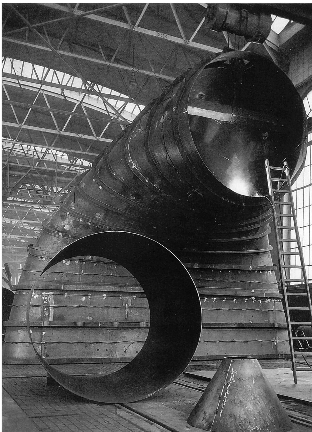
Schweissarbeiten am Saugrohr einer Kaplan-Turbine bei Escher Wyss
