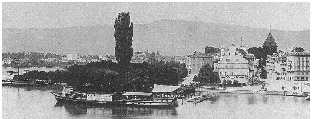
Beim Bauschänzli befand sich die erste Sandfilteranlage.
