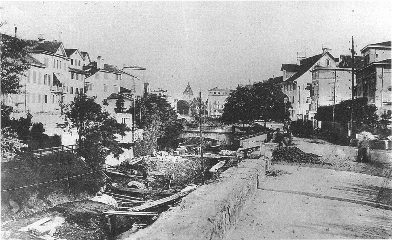
Eindeckung des Fröschengrabens für den Bau der Bahnhofstrasse 1864, ganz im Hintergrund der Kratzturm
