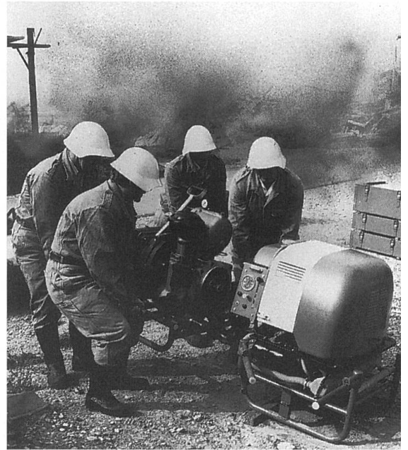
Der schweizerische Zivilschutz verwendet Kompressoren, die neuerdings durch Sulzer-Burckhardt hergestellt werden. Deren Konstruktion stammt jedoch aus der Schweizerischen Lokomotiv- und Maschinenfabrik.
