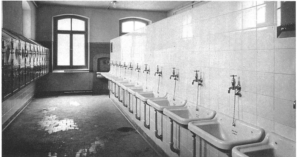
Waschraum der Brauerei mit Wandkästen für die persönliche Habe der Angestellten
