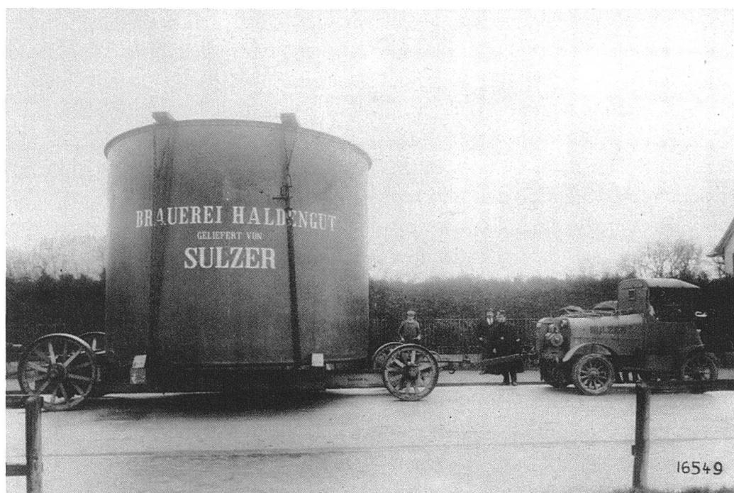
Verdampfer zur Kühlanlage (1922)
