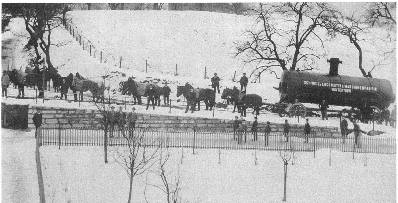
Ein neuer Dampfkessel wird zum Haldengut hinaufgezogen
