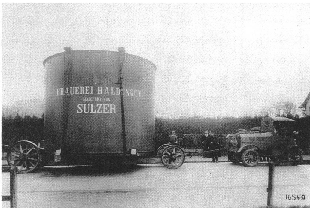
Verdampfer zur Kühlanlage (1922)
