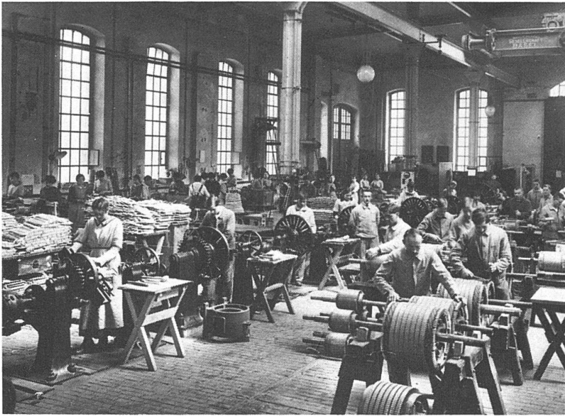
Motorenwicklerei von Brown Boveri in Münchenstein BL 1915
