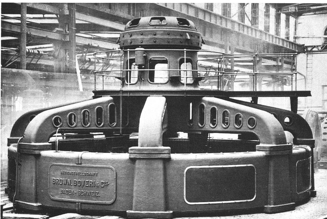
Generatorgehäuse für das Kraftwerk Olten- Gösgen 1915
