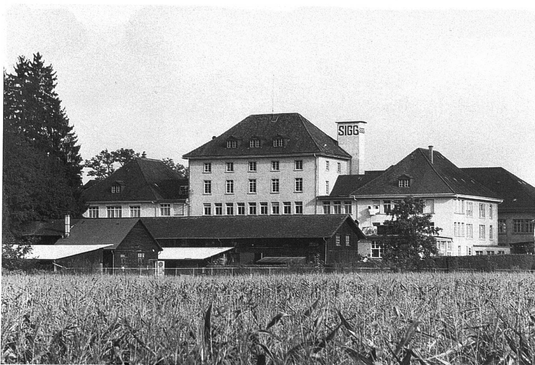
Die ehemalige Walzmühle
