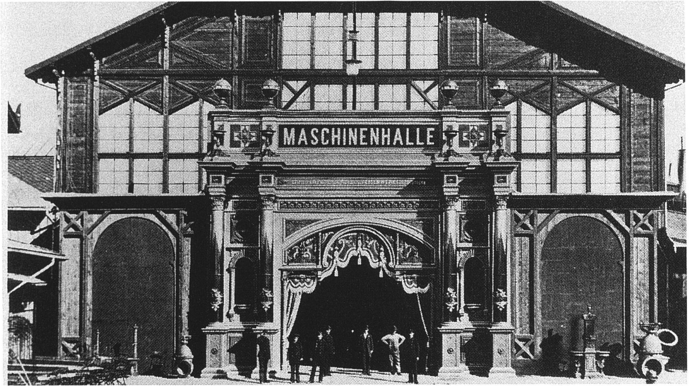
Die Maschinenhalle der Landesausstellung in Zürich von 1883, an der Martini grosse Erfolge hatte. Sie stellte eigentlich den Höhepunkt seiner Laufbahn dar.
