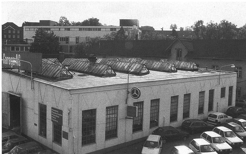
Die 1905 von Ingenieur Karl Löhle erbaute Montagehalle
