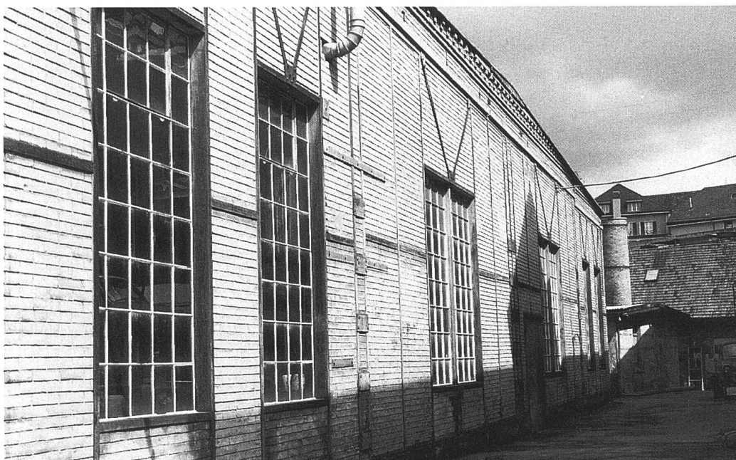
Detail des Eisenfachwerkbaus; ebenfalls ein industriegeschichtlich wichtiger Bau
