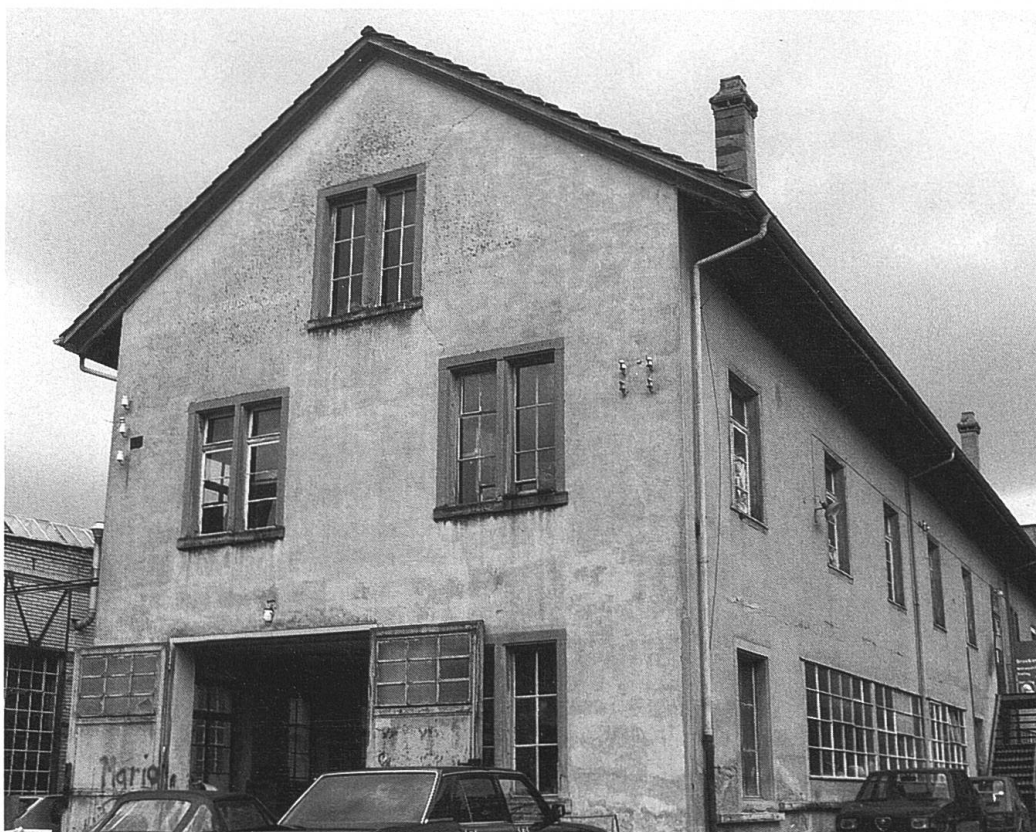
Das älteste, bis Ende 1991 noch erhaltene Gebäude aus dem letzten Viertel des 19. Jahrhunderts
