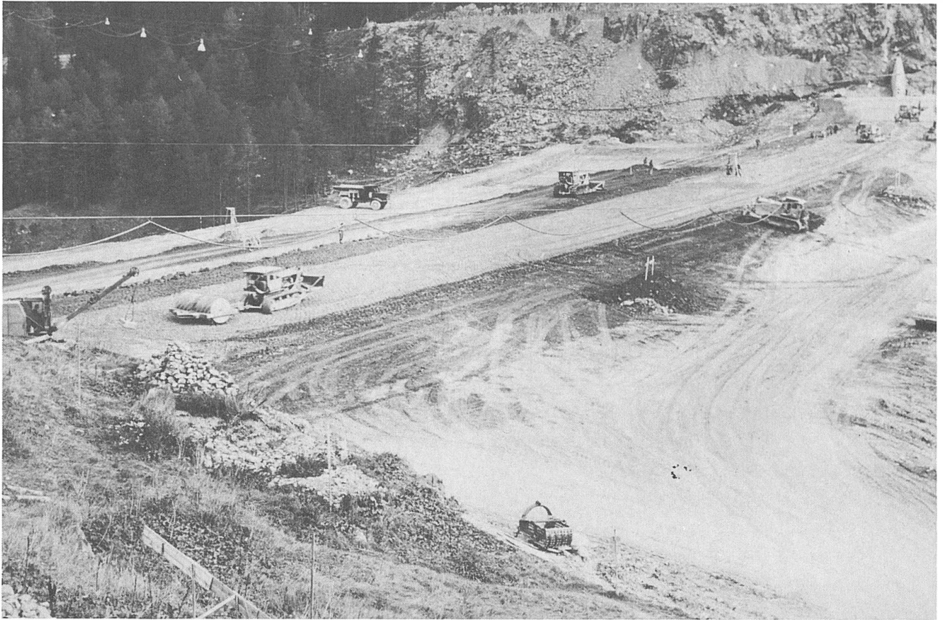
Bauaufnahme des 1950 bis 1954 erstellten Erd- dammes Castiletto bei Marmorera in Grau- bünden
