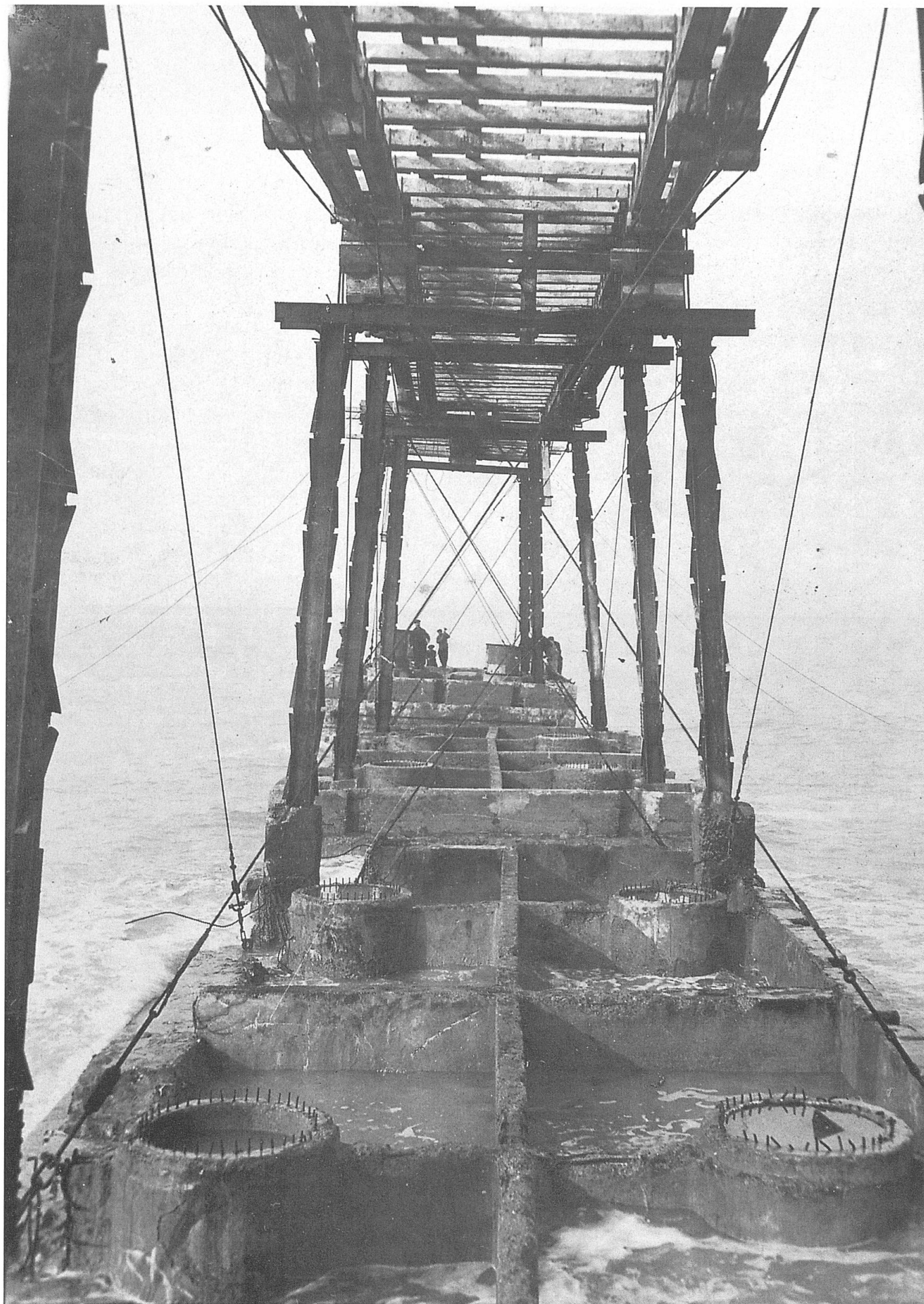
Caissons für die Hafen- mauern in Dieppe 1905
