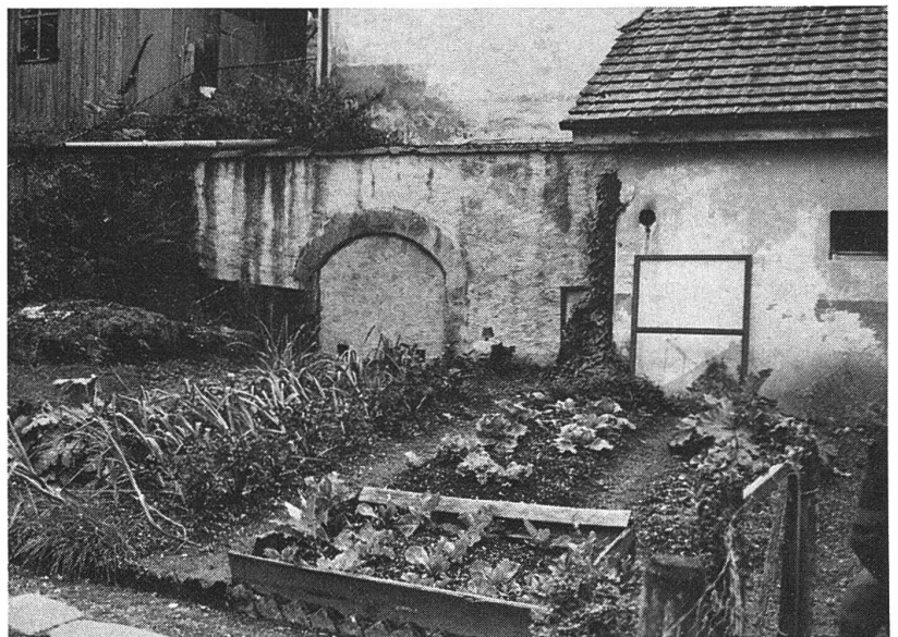
Eingang zum Stollen Allmendgütli, erbaut zur Zeit von Clais
