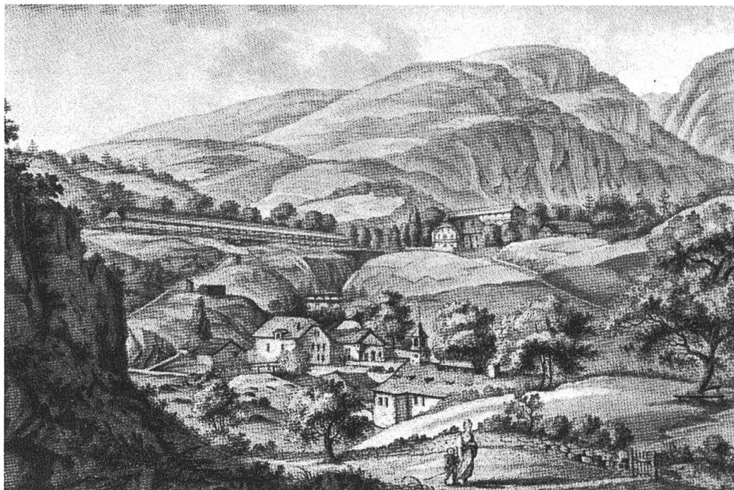
Saline von Bévieux bei Bex, Blick von Süden, 1800
