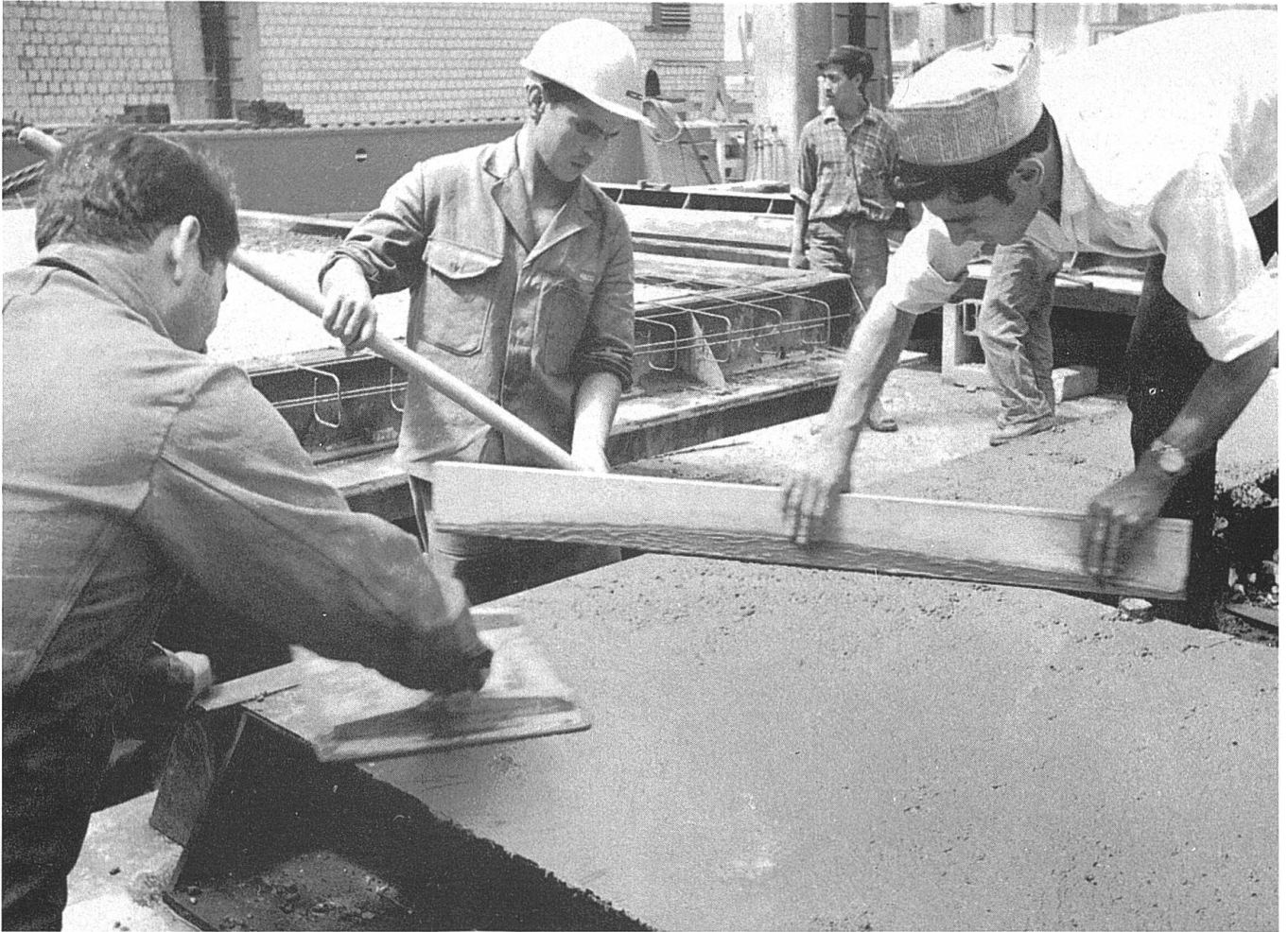
Die Fassadenelemente wurden auf horizontalen Stahltischen hergestellt. Sie bestanden aus einer äusseren Betonplatte von 7 cm und einer inneren von 10 cm Stärke sowie einer dazwischenliegenden 4 cm dicken Styropor-Isolierschicht
