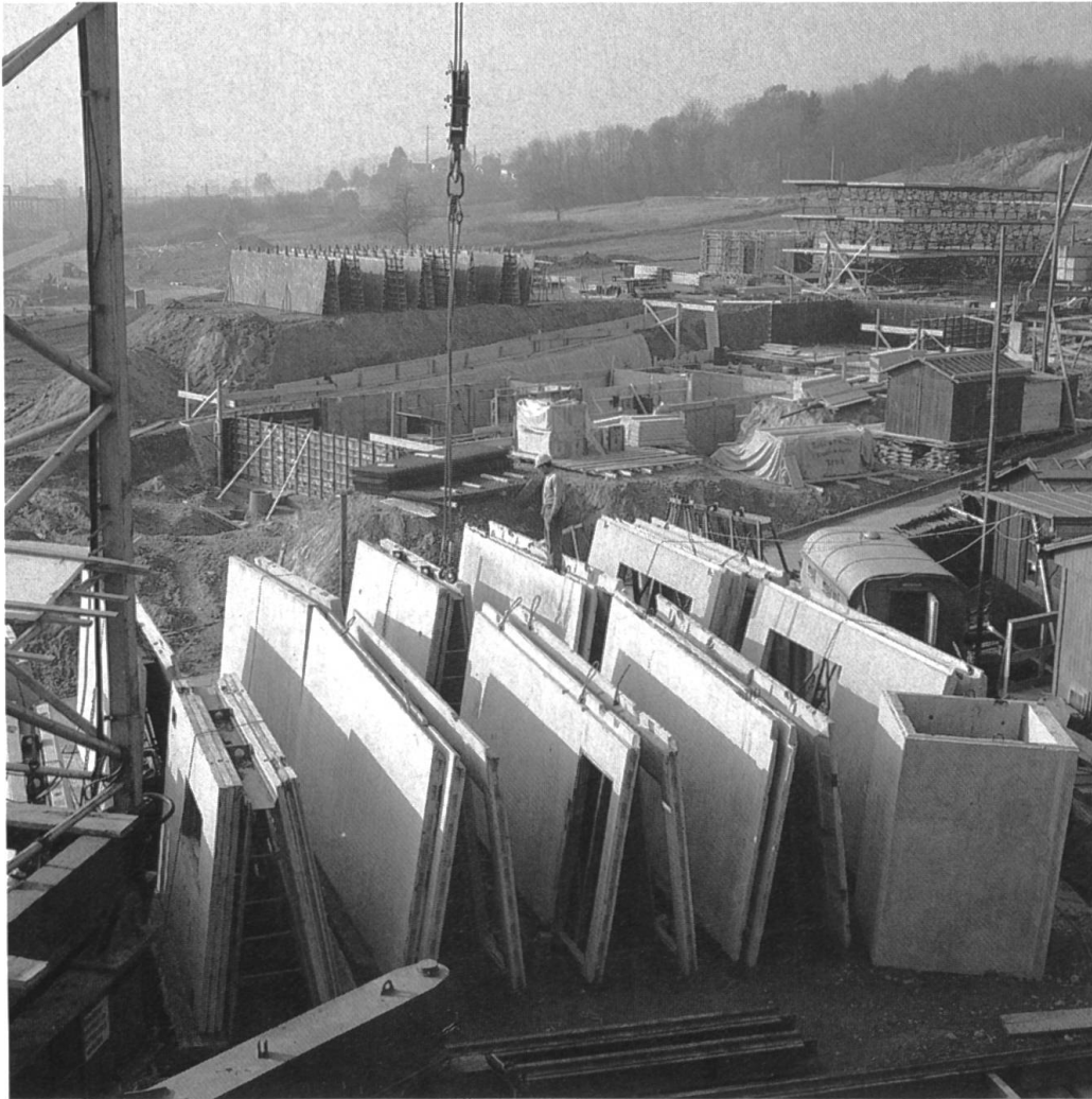
Auf dem Bauplatz wurden die Elemente in ein Zwischenlager eingereiht, sofern sie nicht direkt versetzt werden konnten
