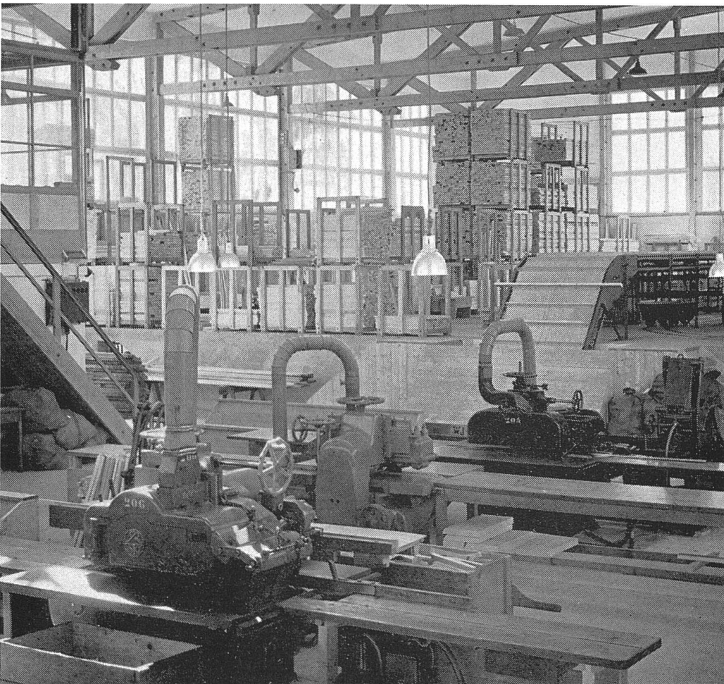
Die 1948 nach modernsten Grundsätzen mechanisierte Zuschneidehalle der TUFA AG
