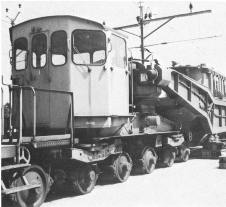
Umsetzen eines 100-Tonnen-Transformers vom Bahn- aufs Strassenchassis
