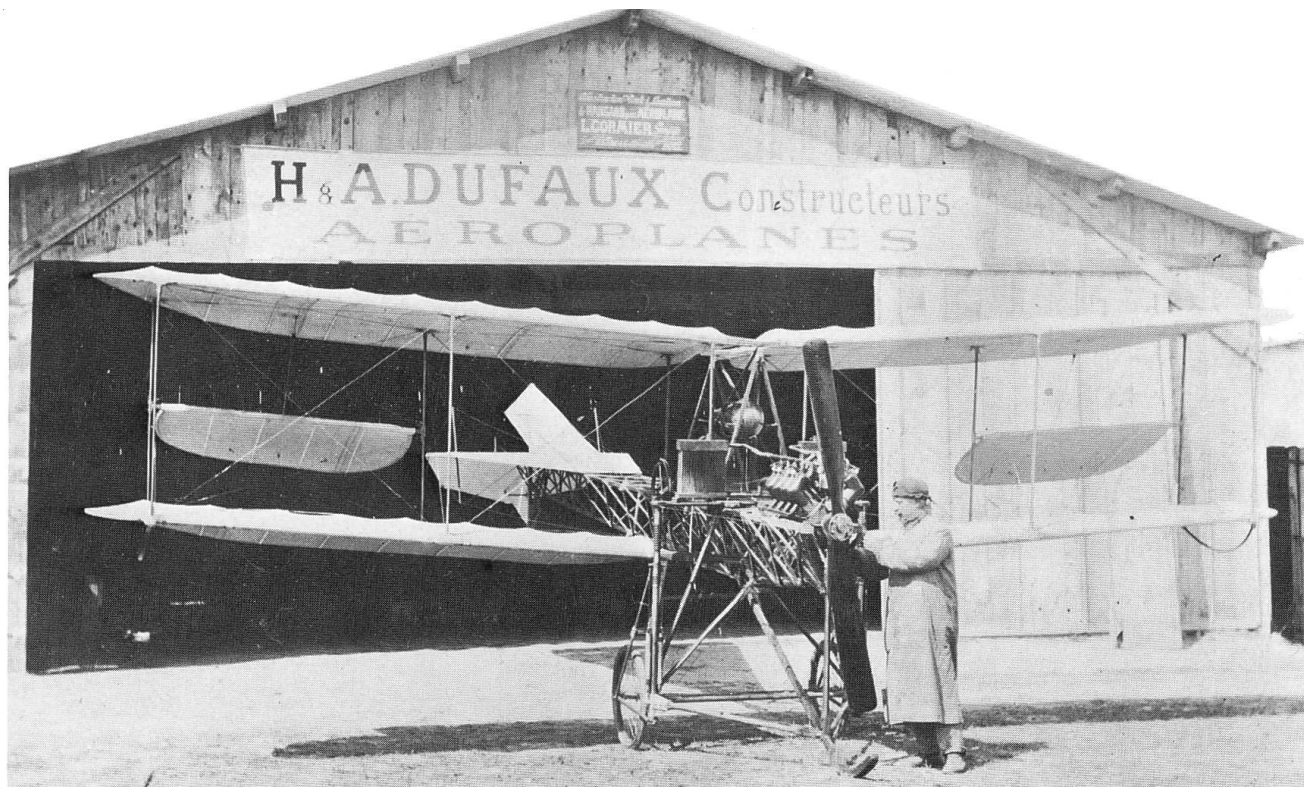
Konstruktionswerkstätte der Gebrüder Dufaux in Genf mit Doppeldecker, ausgerüstet mit Antoinette-Motor
