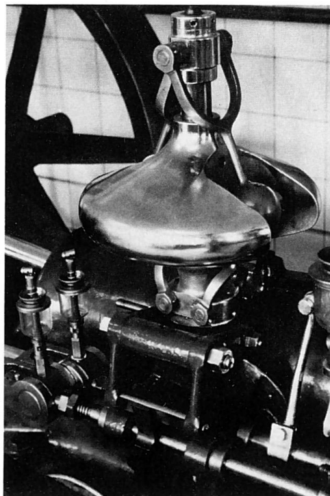
Sulzer-Dampfmaschine mit Bodmer-Steuerung (Detail)
