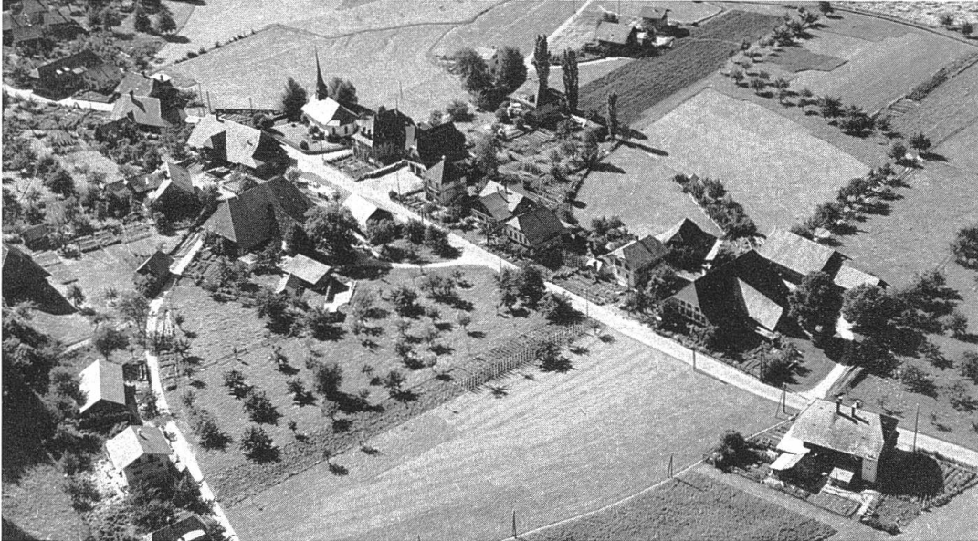
Beispiel eines intakten Bauern- dorfes (Hasle BE)
