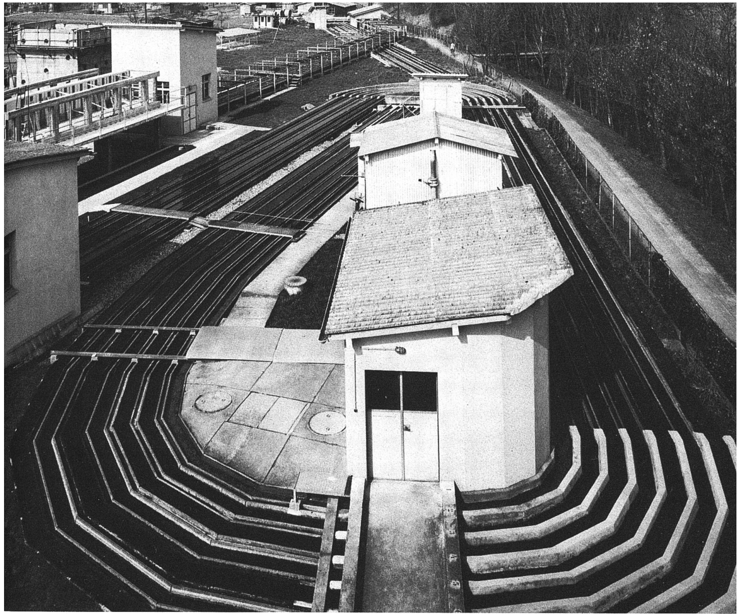
Versuchsanlage Tüffenwies: das aus sieben je 200 m langen Kanälen bestehende System der Test-Rinnen.
