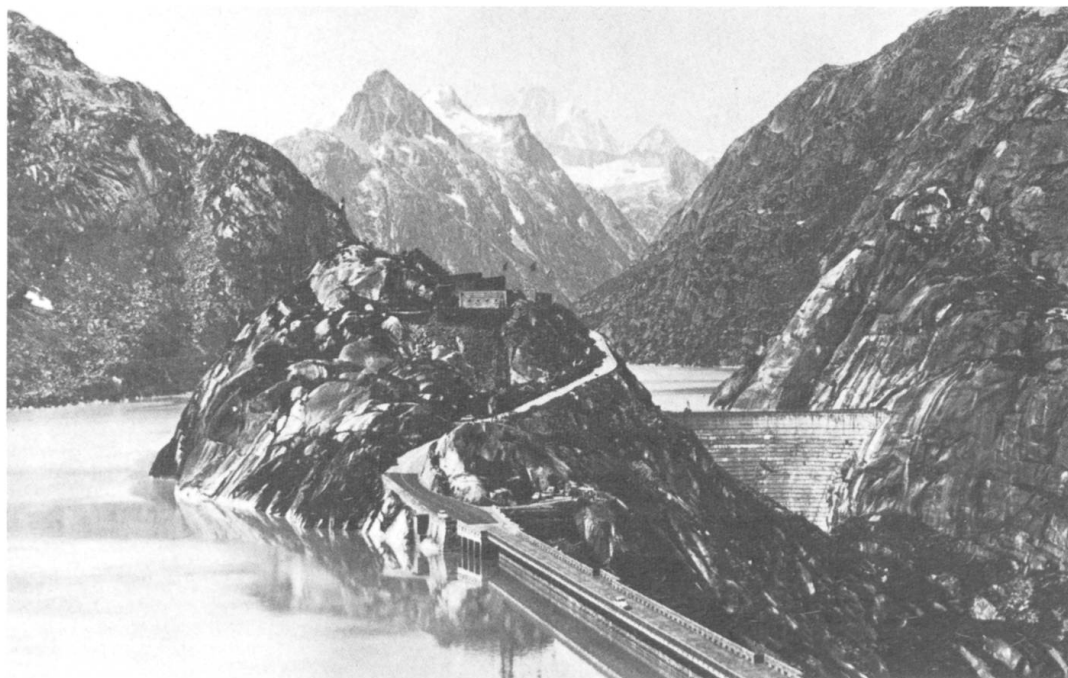
Kraftwerke Oberhasli, Nollen und Staumauern Grimselsee
