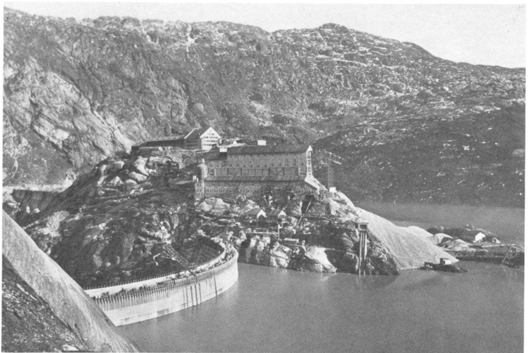
Der Stau erreicht die Spitallammsperre
