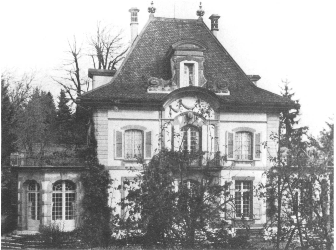
Villa Laubeggstrasse 45, Bern, erbaut von H. B. von Fischer, nach dem Zweiten Weltkrieg abgerissen
