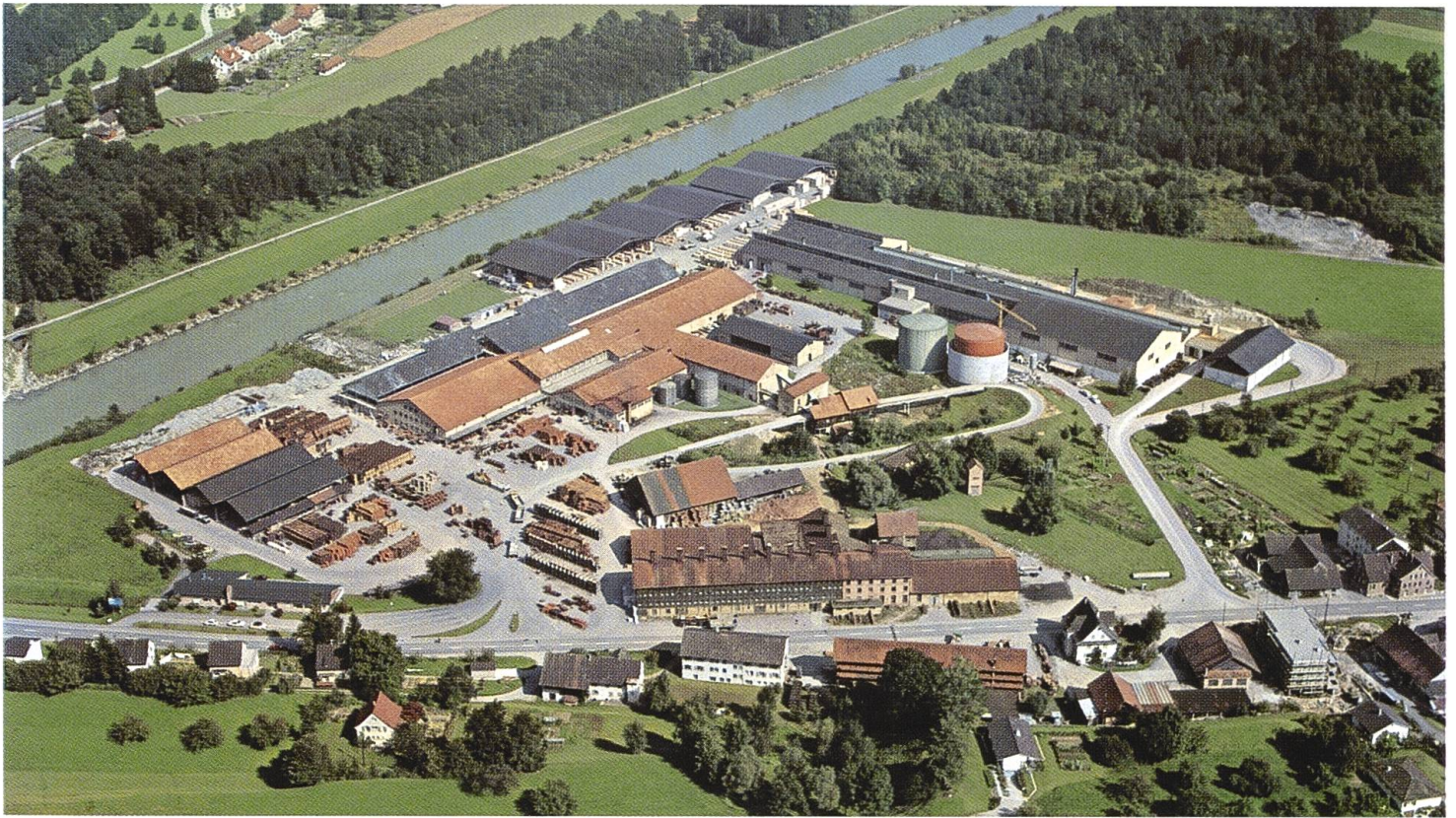
Istighofen an der Thur in der Nähe von Weinfelden ist der größte Betrieb der Zürcher Ziegeleien. Er wurde 1899 erbaut, 1908 der Firma Schmidheiny & Co. angegliedert und stufenweise ausgebaut. Im Werk II (obere Bildmitte) werden Dachziegel, im neuen Werk III (Bildmitte rechts) Backsteine, Hochhaussteine und Deckensteine hergestellt. Die Jahresleistung dieser beiden Werke betrug zur Zeit der Aufnahme dieses Bildes (1970) rund 100 000 Tonnen.
