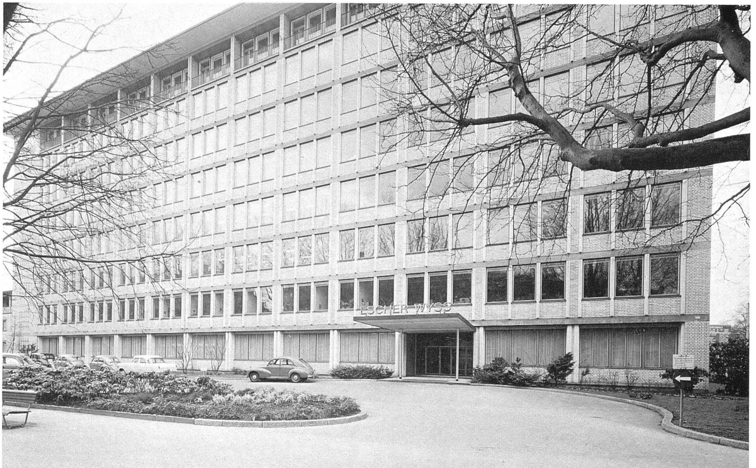
Das neue Verwaltungsgebäude wurde im Jahr 1953 bezogen.
