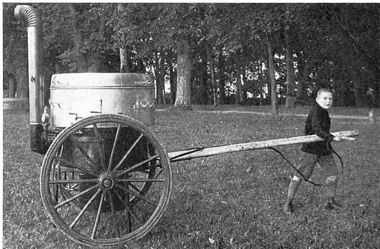
Daß Loders Apparat die Bezeichnung «Kanone» erhielt, wird aus diesem Bilde (fahrbarer Tiefdruckkessel) klar.
