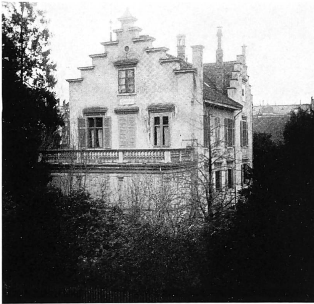
Das «Venedigli» in Zürich-Enge, im 16. und 17. Jahrhundert als kleines Wasserschloß erbaut, wurde 1875 von der Nordostbahngesellschaft erworben und dem Präsidenten der Direktion – damals Friedrich Peyer im Hof – als Amtswohnung zur Verfügung gestellt. An diesen 1925 abgebrochenen Bau erinnert noch der Name der Venedig-Straße (Baugeschichtliches Archiv der Stadt Zürich im Helmhaus).
