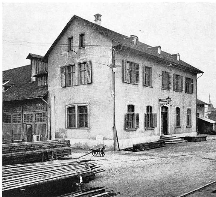
Das erste Verwaltungsgebäude der Waggonfabrik aus dem Gründungsjahr 1855 mit angebauten Werkstätten (Werkauf- nahme SIG).
