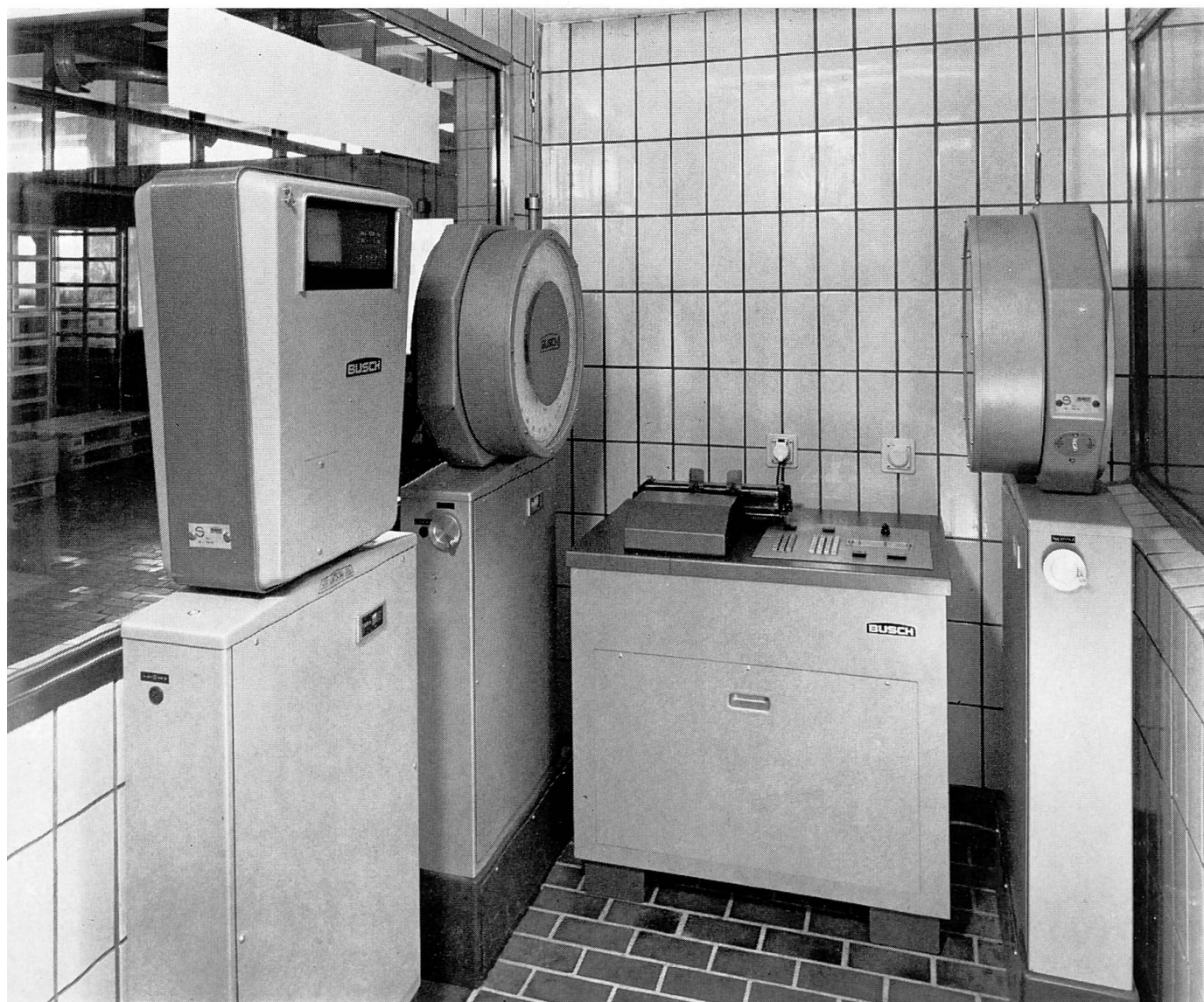
Neue Wäganlage mit Gewichtsregistrierung, kombiniert mit Buchungsmaschine.
