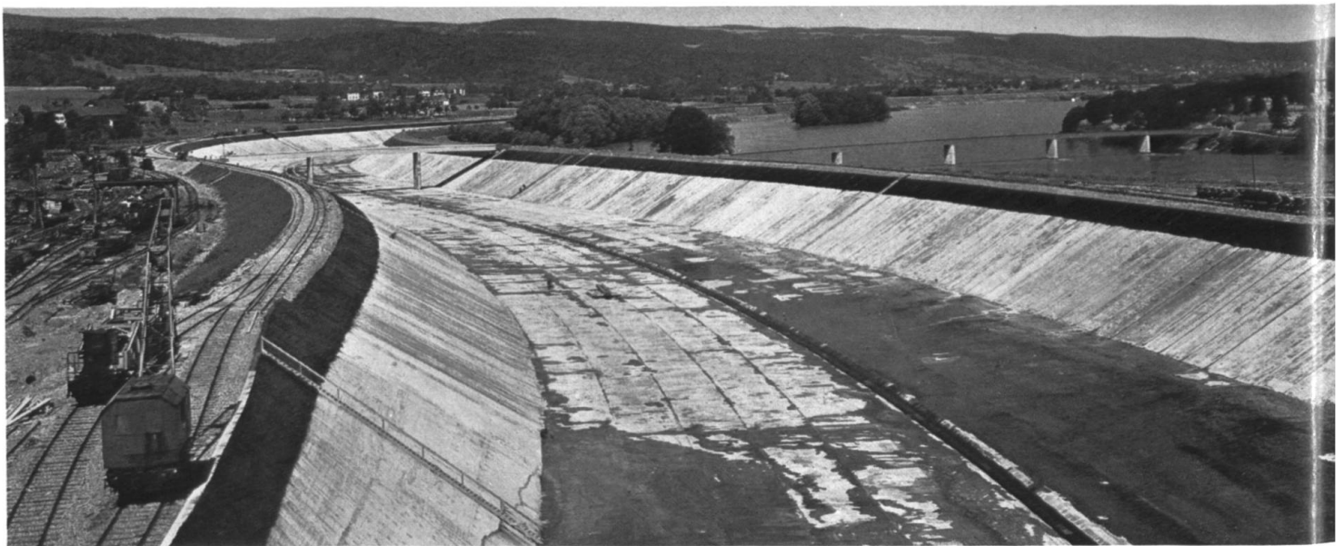
Das Rhein-Kraftwerk Albruck-Dogern. Blick vom Schweizer Ufer auf das Wehr und das Dorf Dogern, dahinter der Schwarzwald. Das Werk besteht aus Wehr, Kanal und Krafthaus.
