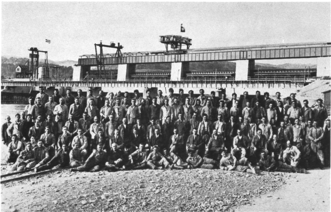
Das Aufrichtefest für das Wehr mit den an seinem Bau beteiligten Gefolgsleuten. Auf den Kranen wehen die Fahnen Deutschlands und der Schweiz.
