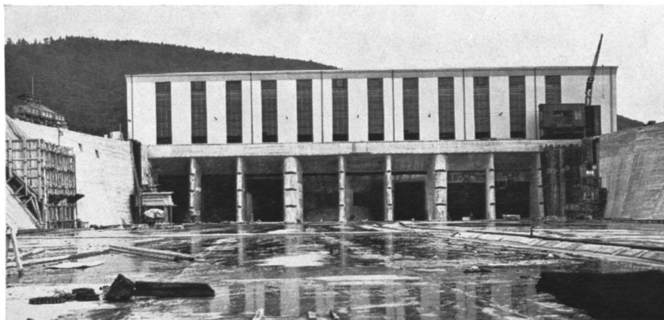
Der Oberwasserkanal mit einer Sohlenbreite von 47,20 Metern vor der Flutung im Juli 1933. Rechts der Rhein, Blick nach Waldshut.
