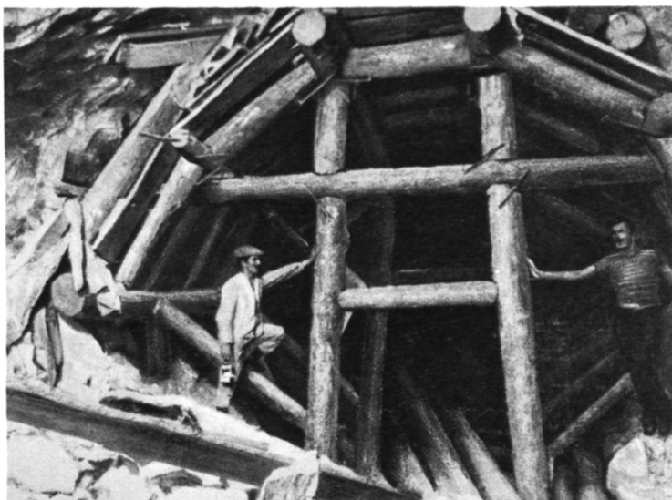
Holzeinbauten im Firststollen.
