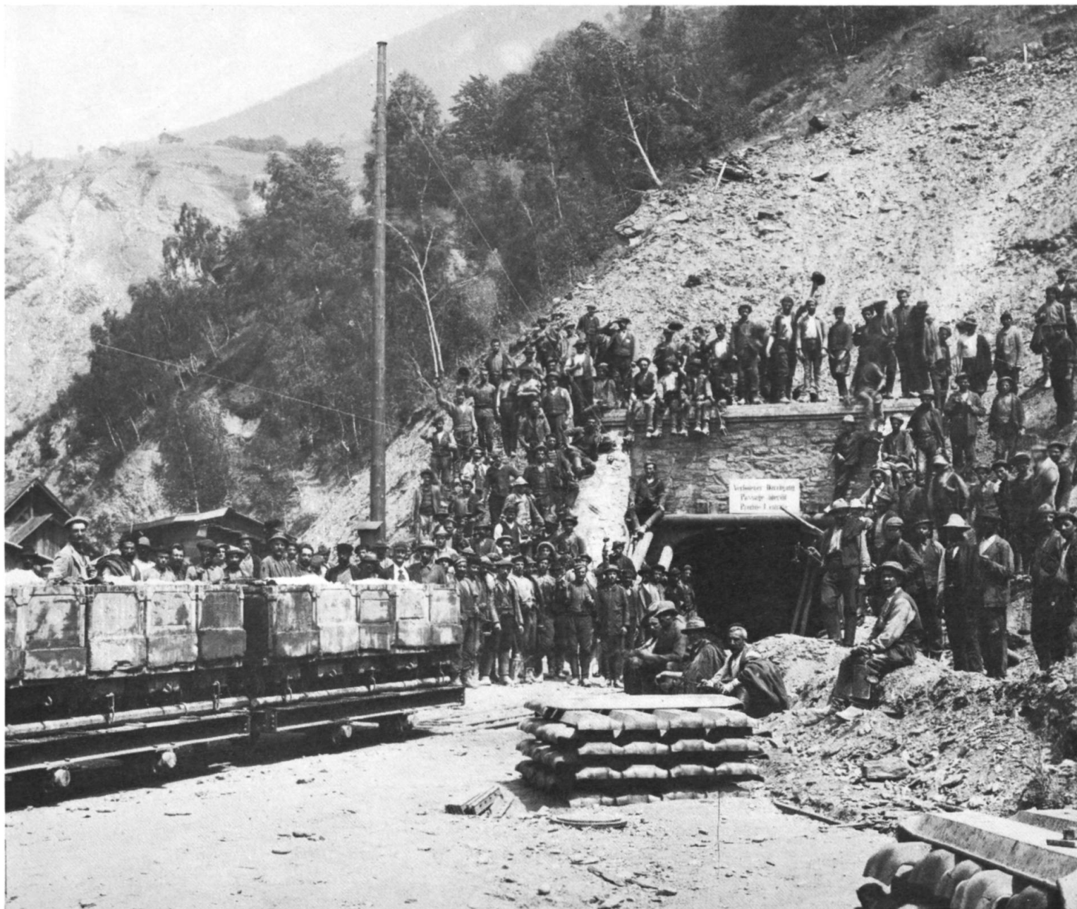
Die Tunnelarbeiter in einer Arbeitspause vor dem Eingang des Stollens, davor 2 Wagen der Transportbahn mit Tunnelaushub.
