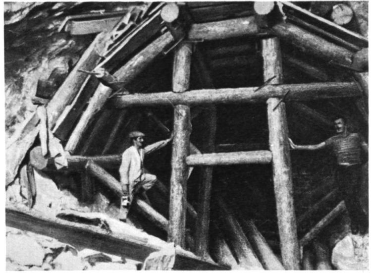
Holzeinbauten im Firststollen.
