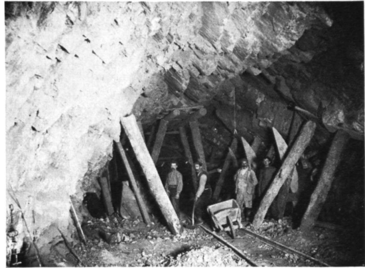
Erste Holzeinbauten beim Tunneleingang I.
