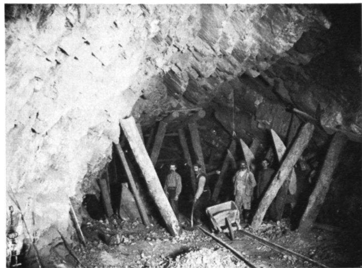
Erste Holzeinbauten beim Tunneleingang I.
