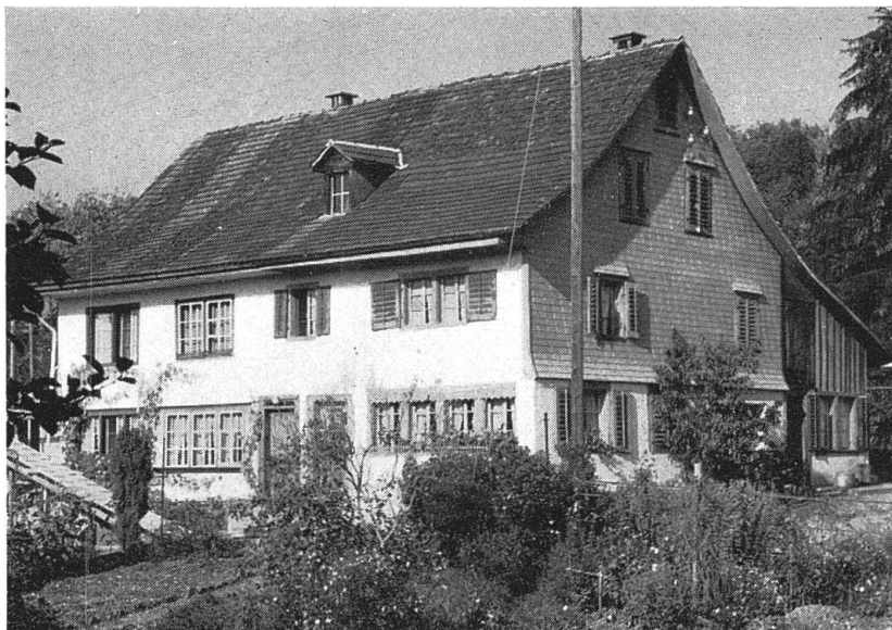
Das Geburtshaus Caspar Honeggers in Rüti, aufgenommen während Erneuerungsarbeiten.
