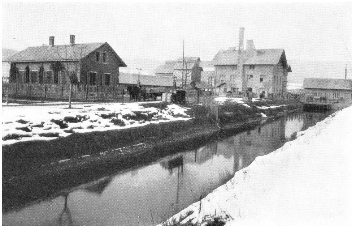
Die Zementfabrik Zurlinden & Cie. in Aarau um das Jahr 1900. Links Büro und Labor, in der Mitte die Zementfabrik mit Ofen- und Mühleanlagen, rechts über dem Kanal das erste kleine Kraftwerk
