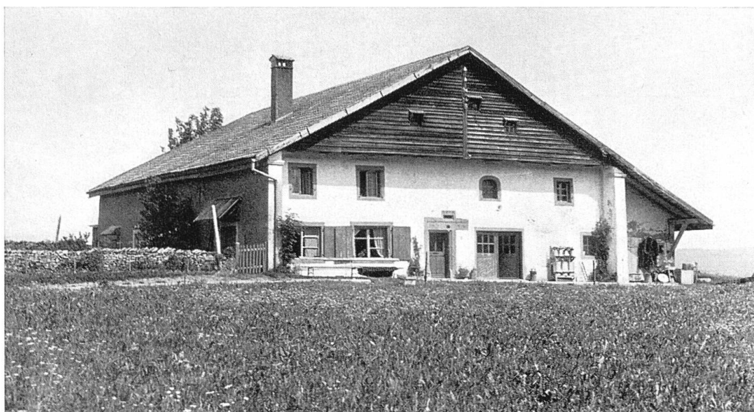
Spruch über dem Eingang des Hauses Nicolet in Trem- bles. Die vier Buchstaben DIRB bedeuten: Daniel JeanRichard (genannt) Bres- sel. (EST = éternellement). Unten: Gesamtansicht des Bauernhauses
