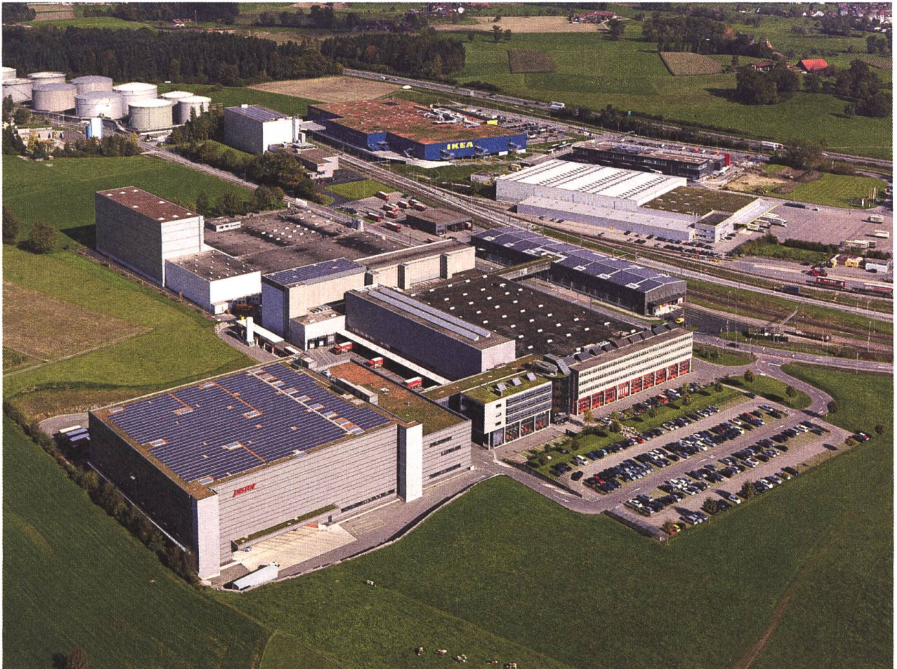
Gut gerüstet für die Zukunft: das Pistor-Areal 2015.
