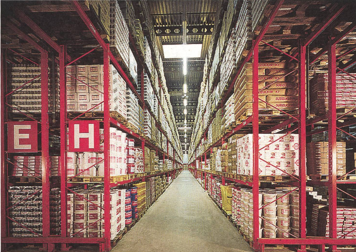
Beim Neubau des Verwaltungsgebäudes wurde auch das Pistor-Warenlager neu konzipiert.
