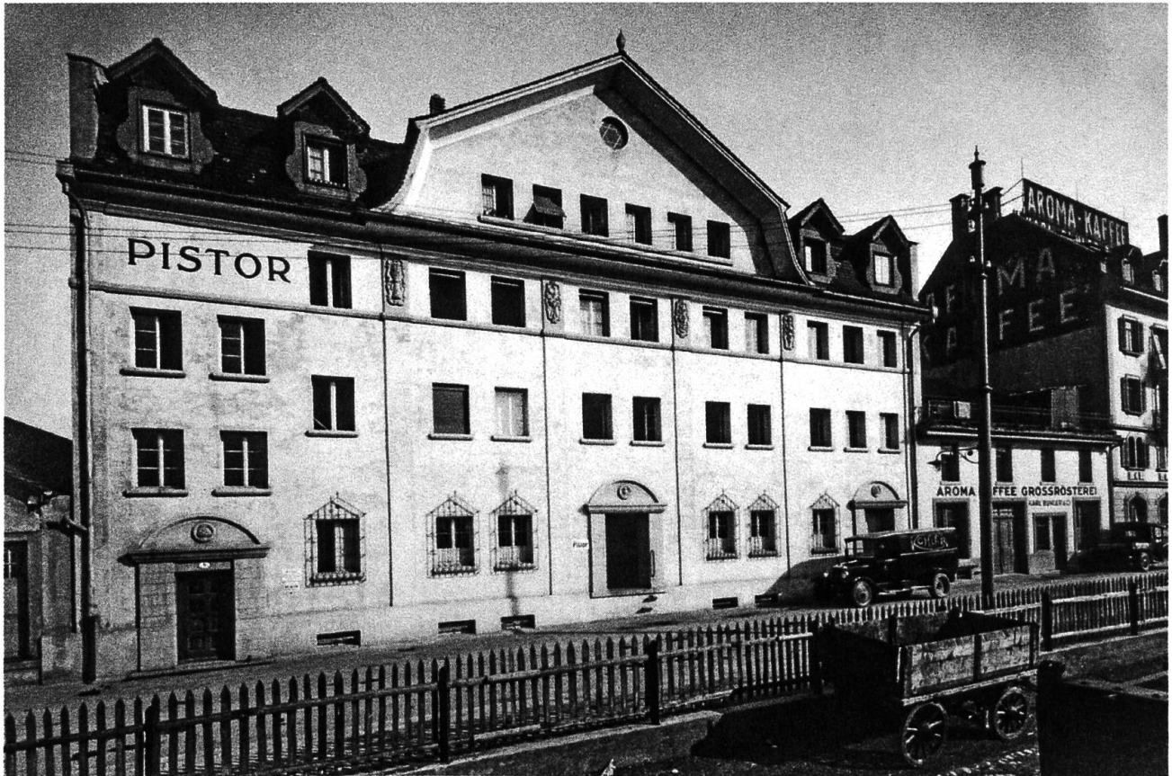
Am 8. März 1925 wurde das neue Waren- und Lagergebäude von Pistor an der Güterstrasse 5 in Luzern eröffnet. Ansicht von der Strasse her.
