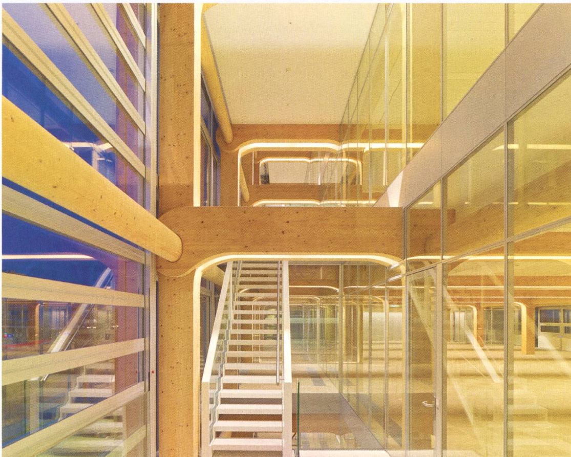
Tamedia-Neubau in Zürich. Die Holzkonstruktion erstellte die Firma Blumer-Lehmann aus Gossau mit Hilfe einer Lignamatic, 2012. Zu sehen: Kaskadentreppe.
