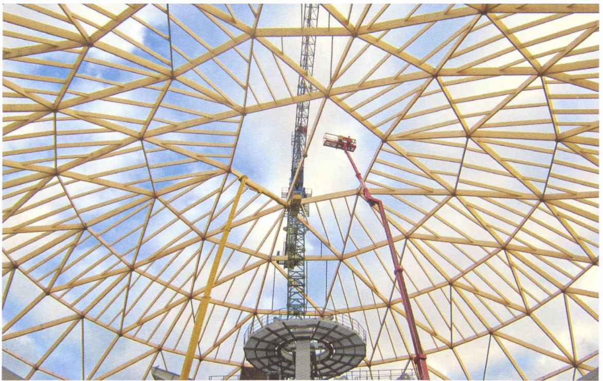
Weitgespannte Dachkonstruktion aus Holz (115m) beim Steinkohle-Kraftwerk in Hamburg-Moorburg, erstellt von der Firma Amann aus Weilheim (D) mit Hilfe einer Krüsimatic, 2010/11.
