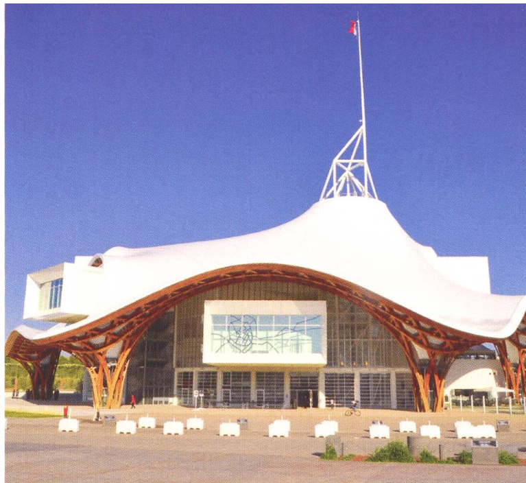
Dachkonstruktion des Centre Pompidou in Metz, erstellt von der Firma Amann mit einer Lignamatic, 2010.
