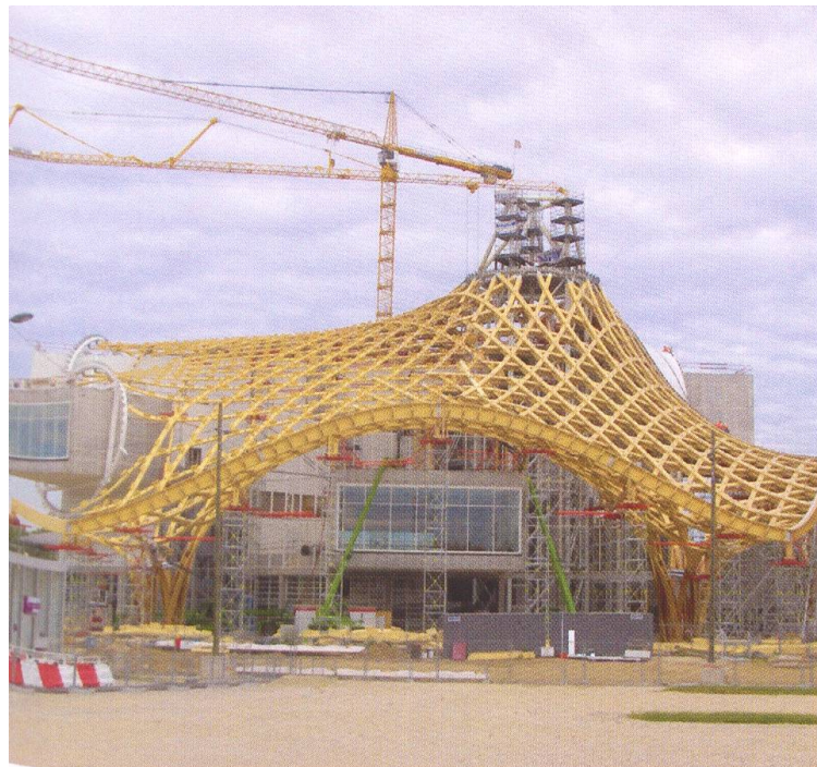
Dachkonstruktion des Centre Pompidou in Metz, erstellt von der Firma Amann mit einer Lignamatic, 2010.
