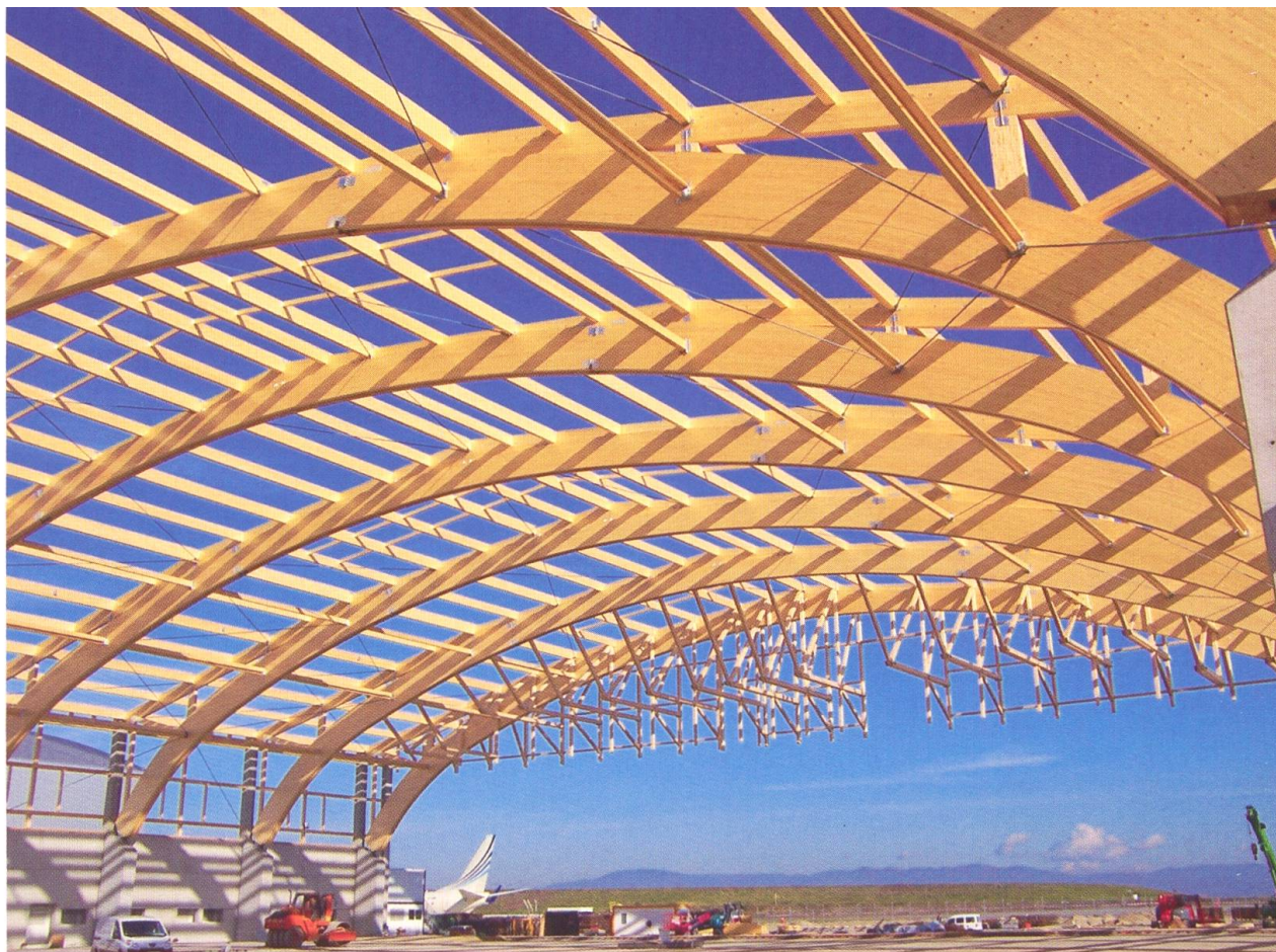
Dachkonstruktion des Flugzeughangars III am EuroAirport Basel Mulhouse Freiburg. Auch für diesen Bau verwendete die Firma Amann eine Lignamatic, 2012.
