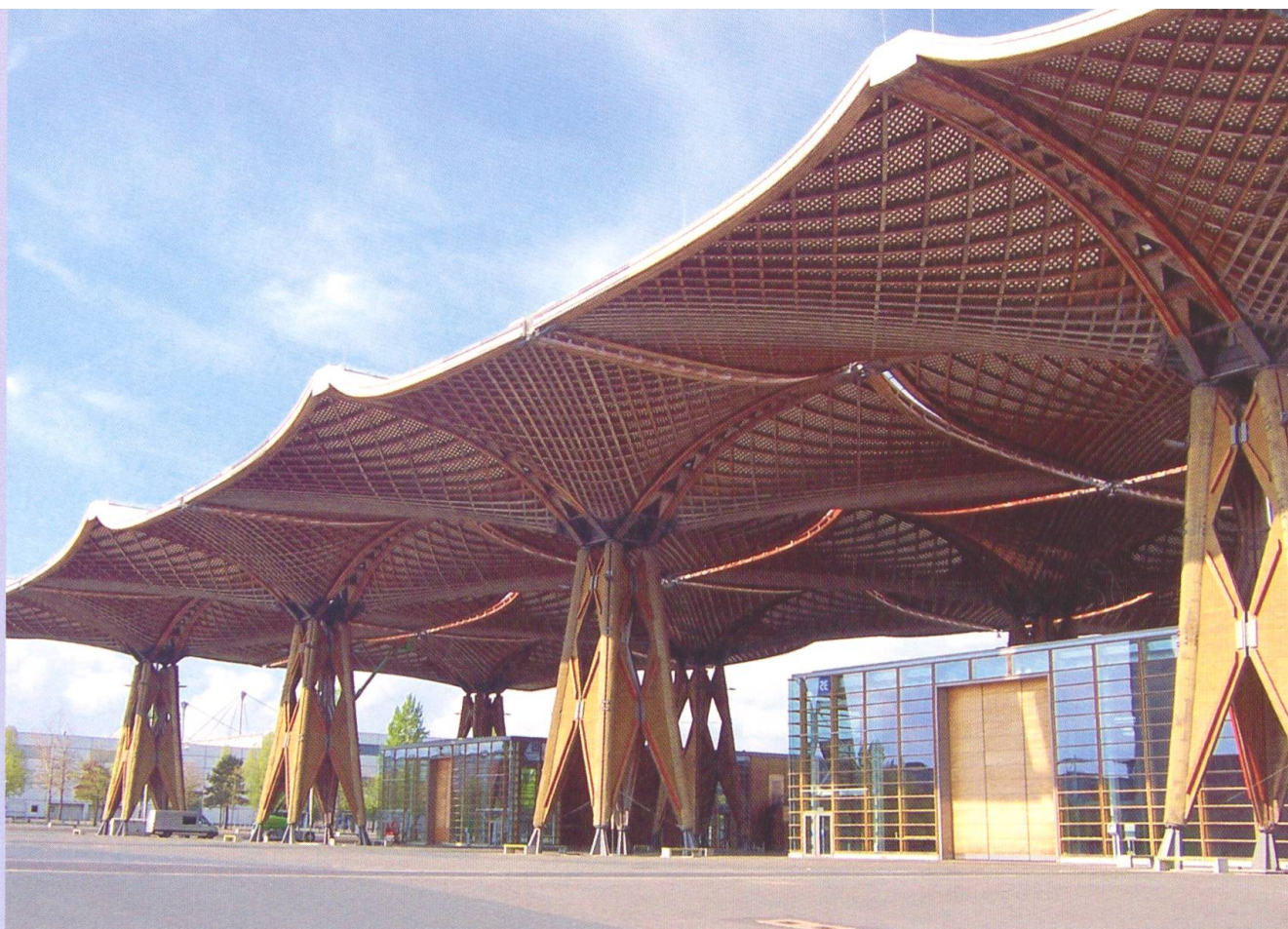
Dach der Expo 2000 in Hannover, erbaut von der Firma Amann mit Hilfe einer Lignamatic.
