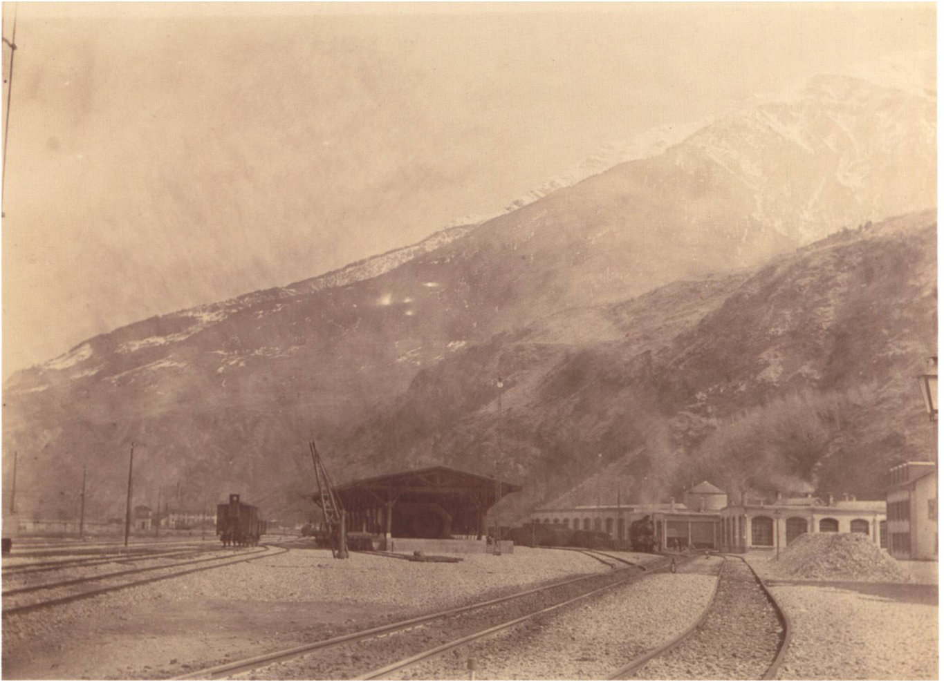
Brig: Stangenloser Dampfbetriebszustand Richtung Tunnel. V.r.n.l. : Lokrotunde mit Drehscheibe, da- hinter Wasserturm - Güterschuppen - links des Güterwagens Quergebäude (abge- brochen) - Stellwerk Nr. 3 - oberer Rotten- steg.
