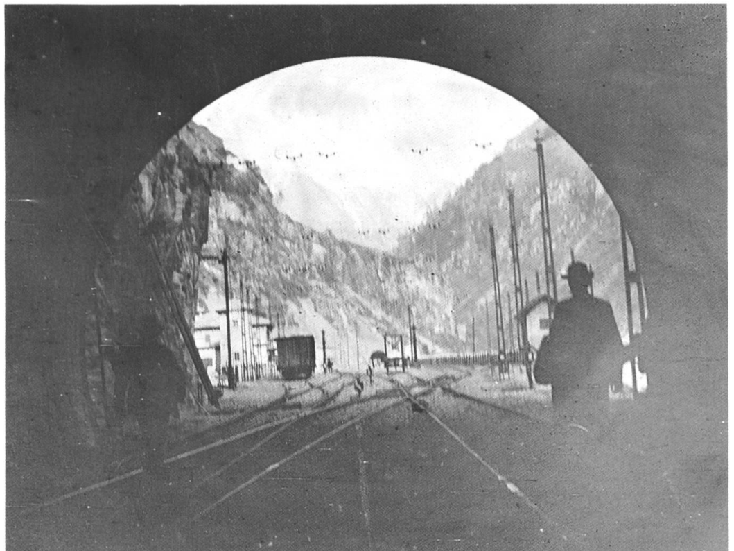
Das Tor zum Süden. Vortunnel-Ausgang mit Bahnhof Iselle di Trasquera. Breite Querdrahtaufhängung.
