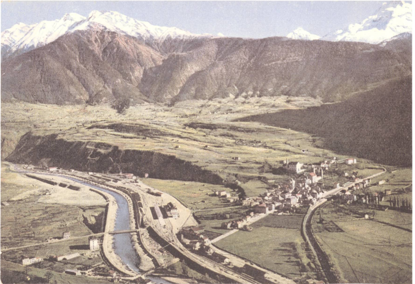
Neues für den Simplonbetrieb bestimmtes, mit Tunnelausbruch aufgeschüttetes Bahnhofareal Brig: v.r.n.l.: unten altes Endstationsgebäude - neues Bahnhofgebäude - Güterschuppen - Verwaltungsgebäude Nordstrasse - Lokomotivrotunde mit Wasserturm für Dampfbetrieb - Güterschuppen - mittlerer Rottensteg (abgebrochen) - querstehendes Industriegebäude (abgebrochen) - oberer Rottensteg (abgebrochen) - Tunnelleingang - gegenüber, am anderen Rottenufer, vermutlich die neuen Dammbauten zur Begradigung mit Terraingewinn für Geleiseanlagen (Postkarte CTK).
