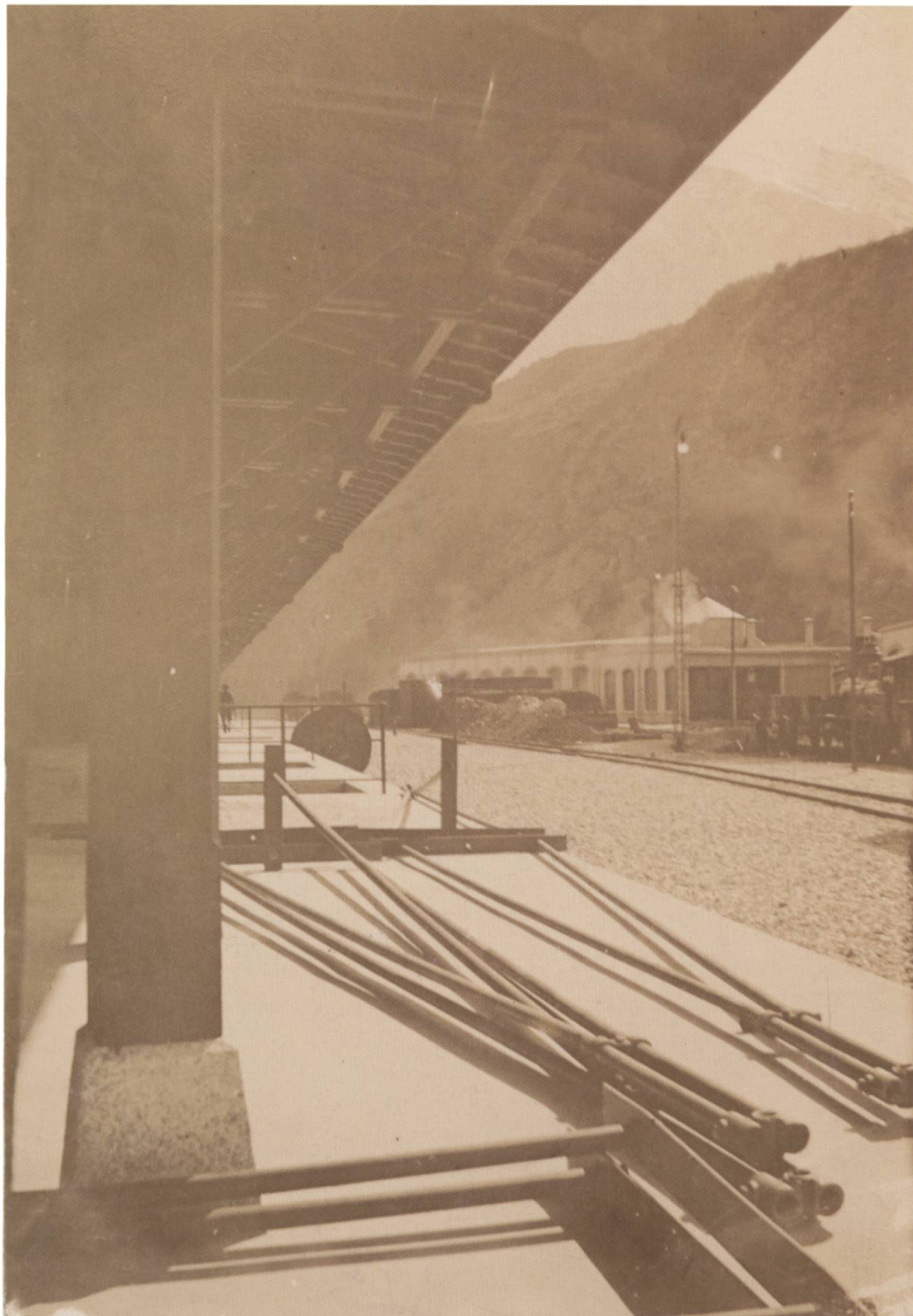
Brig: Zusammengesetzte Gasrohrstützen für die Stangenböcke liegen auf der Güterschuppenrampe zum Aufstellen bereit. Rechts Lokrotunde. Dampflok mit Wagen auf der Drehscheibe.
